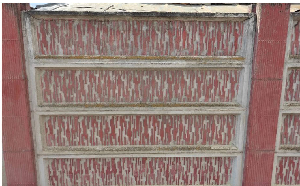
Příloha 19: oplocení soukromého pozemku v Přešticích 143
