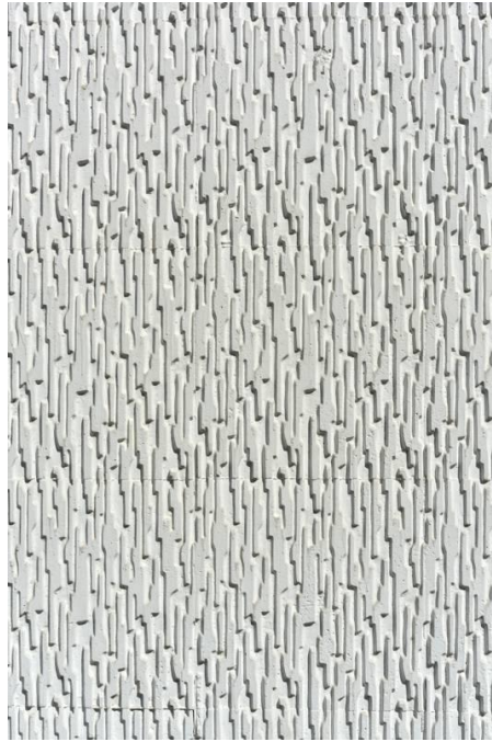
Příloha 16: fasáda Kulturního domu v Teplicích 140
