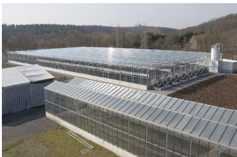
Obrázek 21: Skleníky solární sušárny kalu [2]
