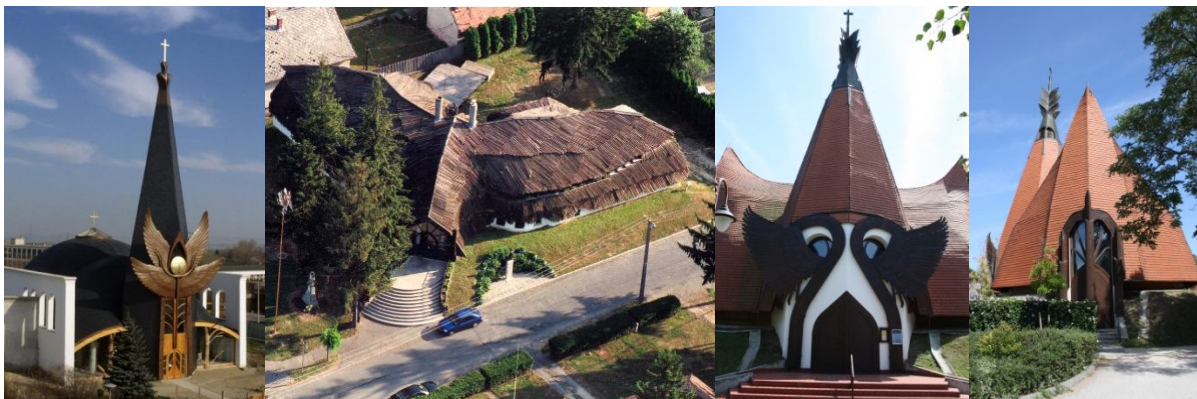
Realizace Imre Makovce zleva: obr. 43- Százhalombatta, římsko katolický kostel; obr. 44 - Bak, Faluház 1985 obr. 45, 46 – Siofok evangelický kostel 1986
