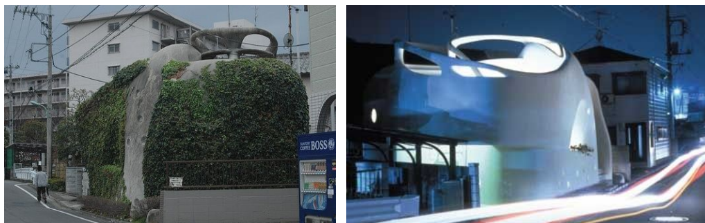
obr. 183, 184 – Eisaku Ushida, Truss wall house, fotografie z hlavní komunikace
