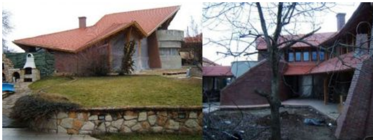
obr. 204, 205 fotografie z výstavby
