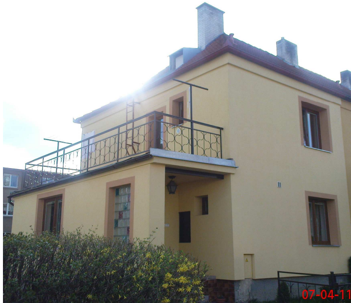
Obrázek 35 Východní strana domu se vstupem
