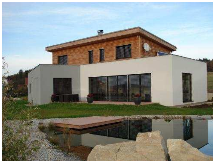
Obrázek 22 Pasivní dům v Písku [25] – orientace prosklení na jih
