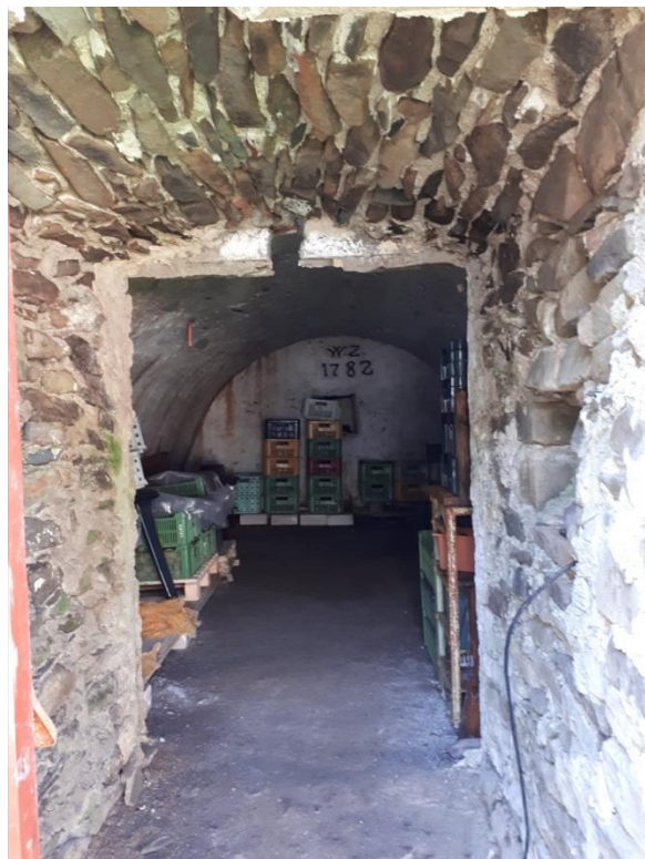
Obr. 69: Holštejn. Dolní mlýn. Klenbový sklep vybudovaný koncem 18. století ve strmém svahu západně od hlavní budovy (foto: V. Kolomazníček, 2018).
