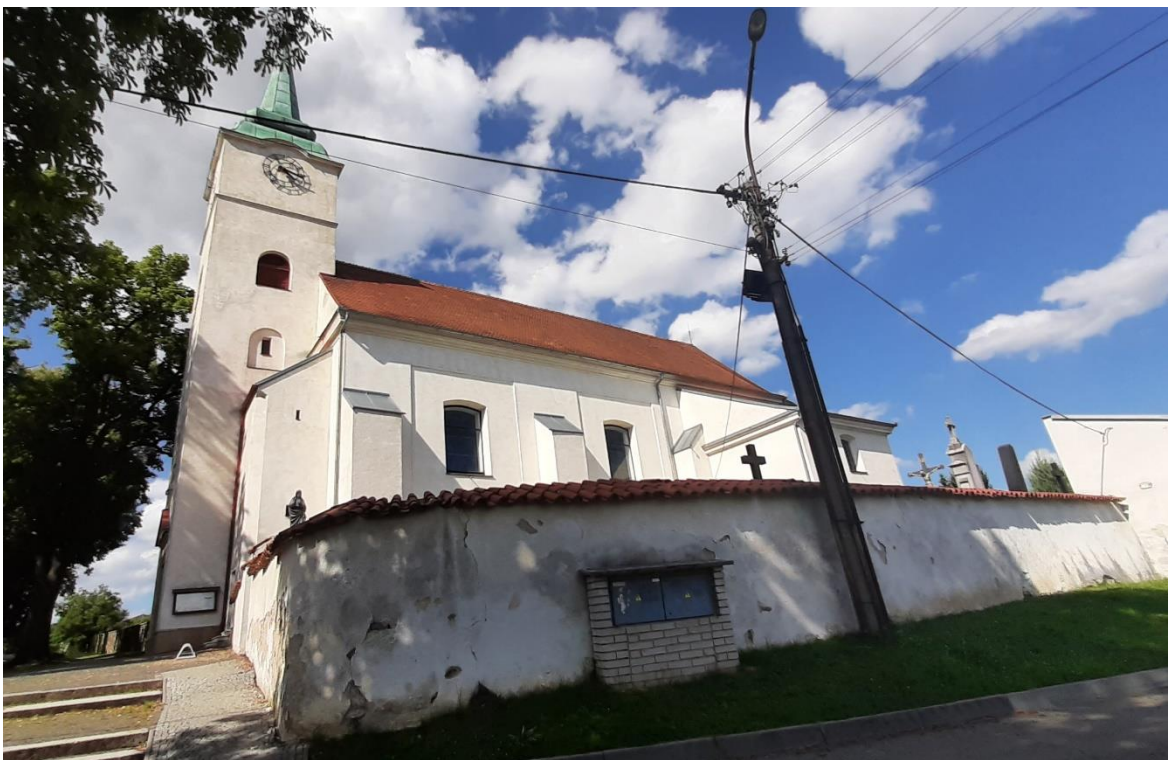
Obr. 35: Kostel sv. Petra a Pavla v Jedovnicích se nachází na vyvýšeném místě v trati zvané Na Valech (foto: V. Kolomazníček, 2021).
