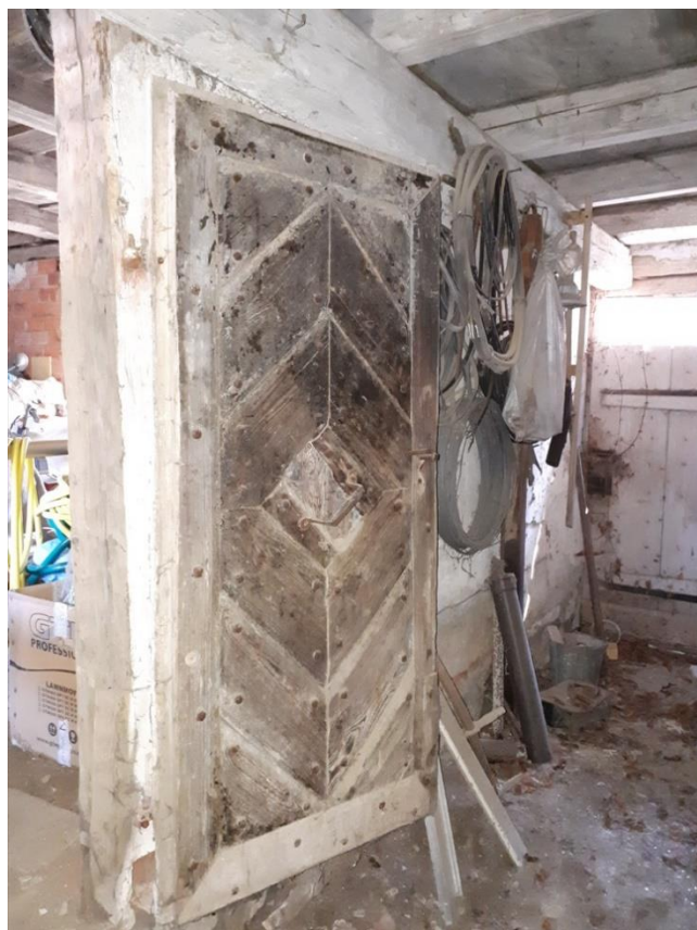
Obr. 70: Holštejn. Dolní mlýn. Masivní barokní dřevěné dveře v prostoru hospodářského traktu Dolního mlýna (foto: V. Kolomazníček, 2018).
