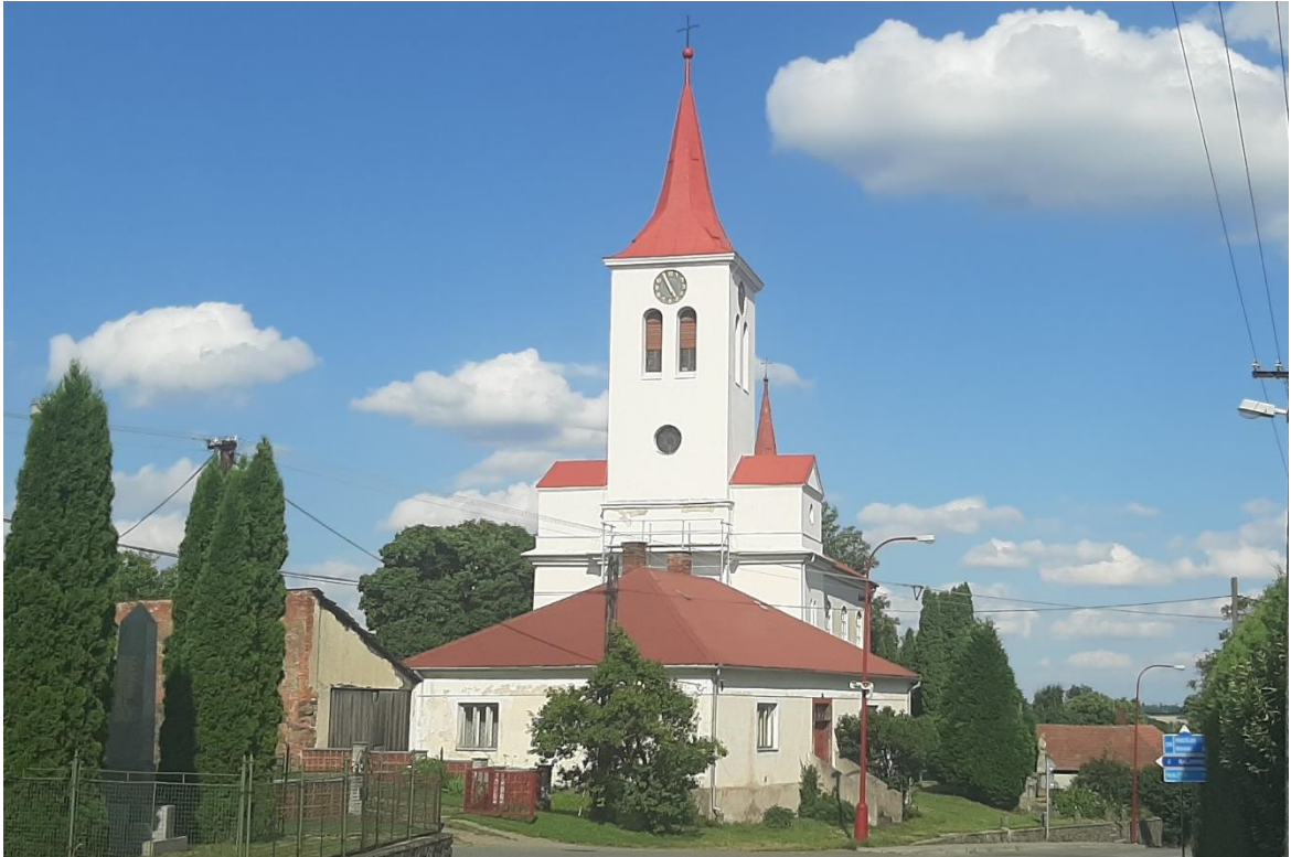
Obr. 38: Kostel sv. Michala Archanděla v Rozstání. Kostel je postaven opět na vyvýšeném místě, které je tak typické pro všechny sakrální stavby zkoumaného území. (foto: V. Kolomazníček, 2021)
