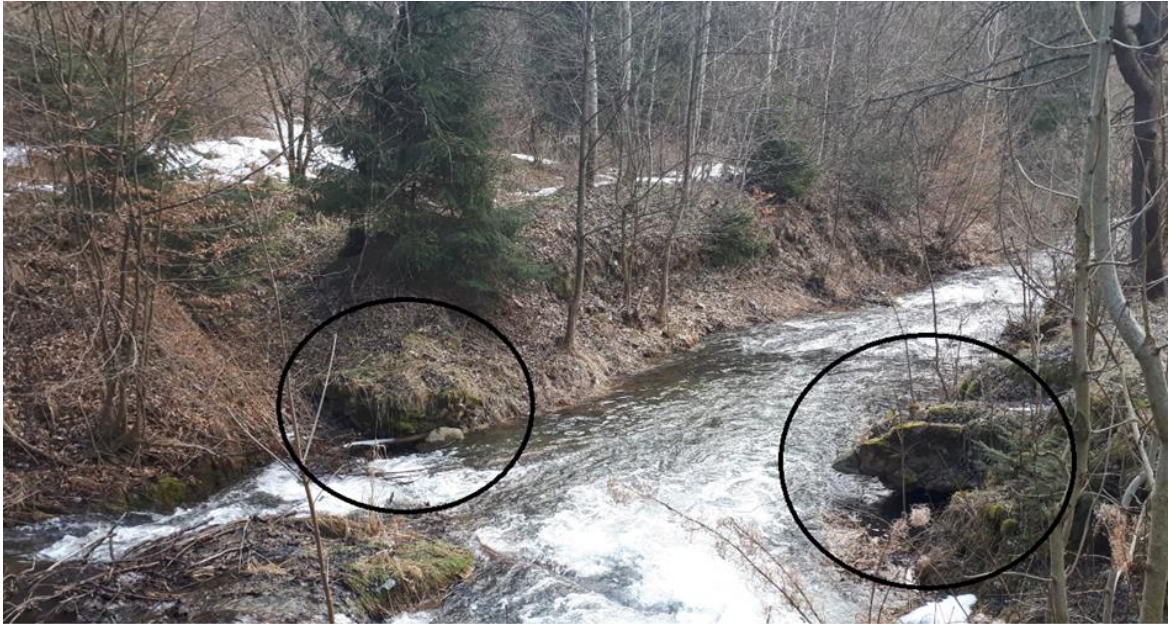
Obr. 151: Relikty kamenného mostu u Holštejna (foto a grafická úprava: V. Kolomazníček, 2019).
