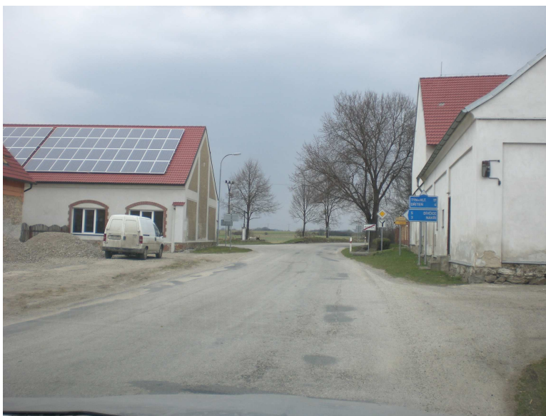
Obr. č. 6 – FVE na střeše domu Olešník
