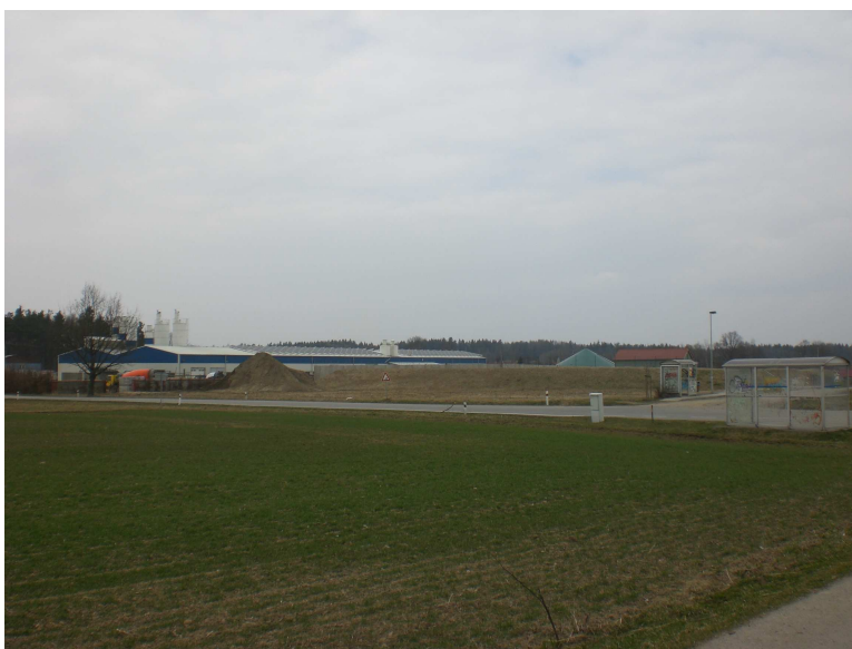
Obr. č. 7 - FVE na střeše Beton Hronek Ohrazeníčko
