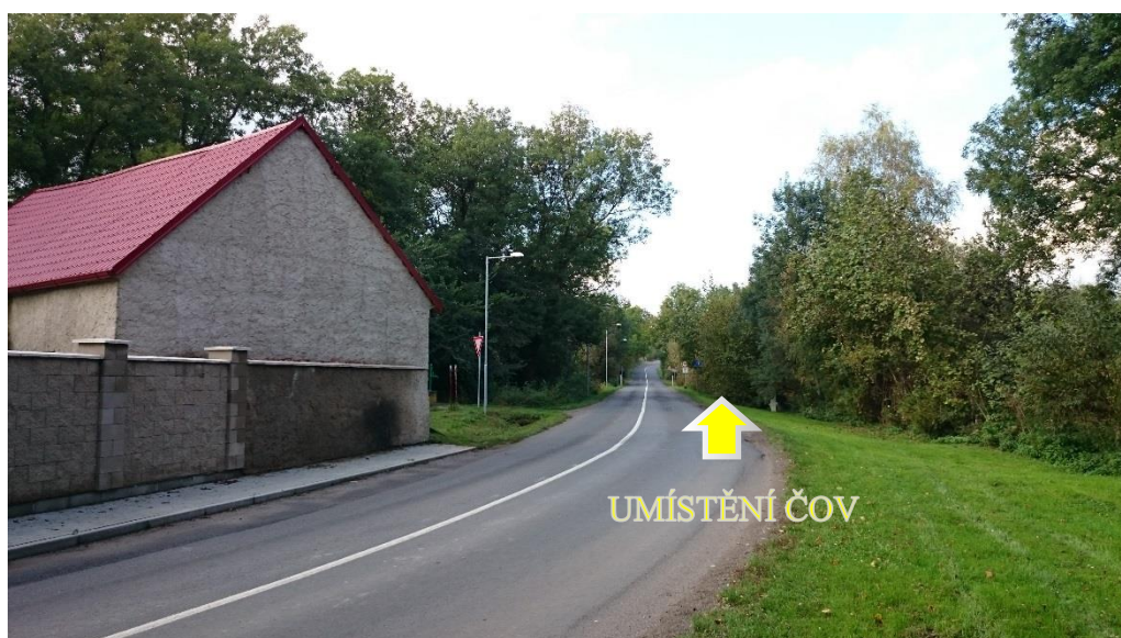
Obr. 19 - Zpevněná asfaltová komunikace (silnice II/246 – Orasice) s plochou pro umístění ČOV
