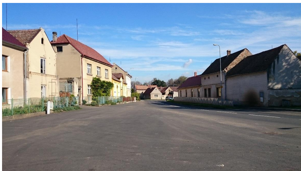
Obr. 13 – Zpevněná asfaltová komunikace (silnice II/246 – Počedělice)
