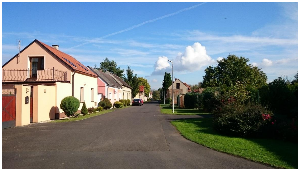
Obr. 14 – Vedlejší zpevněná asfaltová komunikace (Počedělice)
