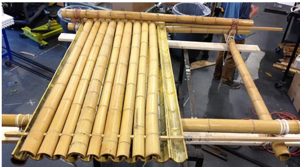
Obr. 14: část přichystané střešní krytiny (Pixgood 2014)
