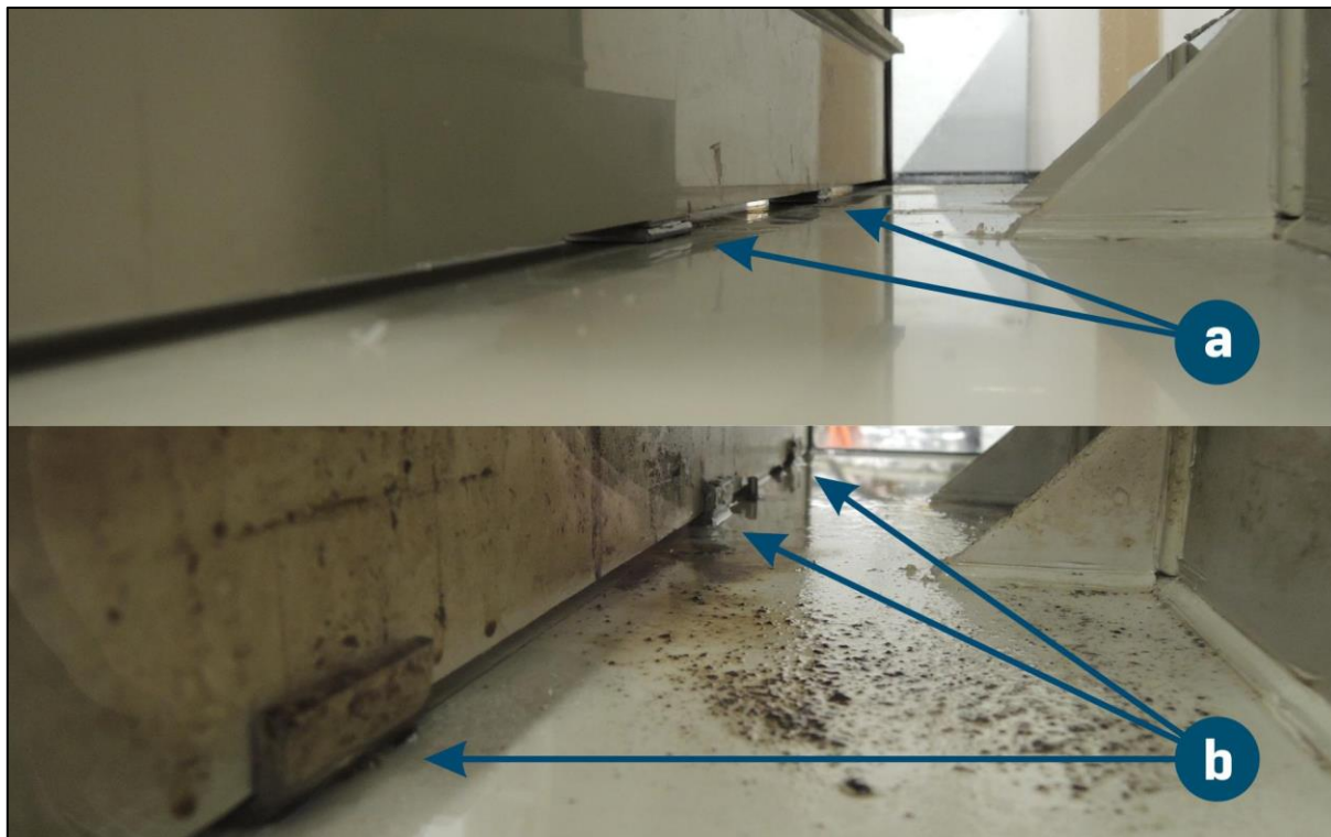
obr. 53: Vyztužení přechodových otvorů před (a) a po úpravě (b). Umístění výztuh je naznačeno šipkami.
