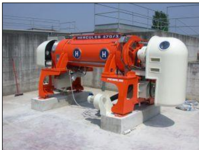
obr. 17: Dekantální odstředivka Hercules 4703 [83].
