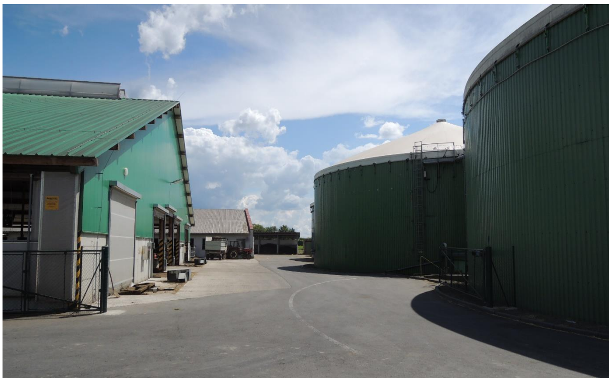
obr. 1: Bioplynová stanice v Kostelci na Hané s charakteristickými fermentačními nádržemi (vpravo).
