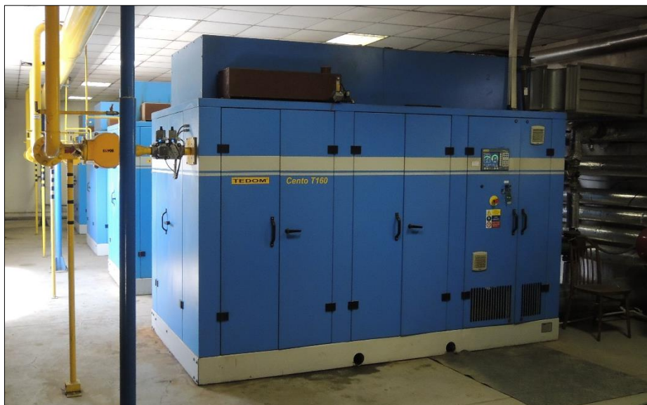
obr. 5: Kogenerační jednotka TEDOM Cento T160 v BPS..
