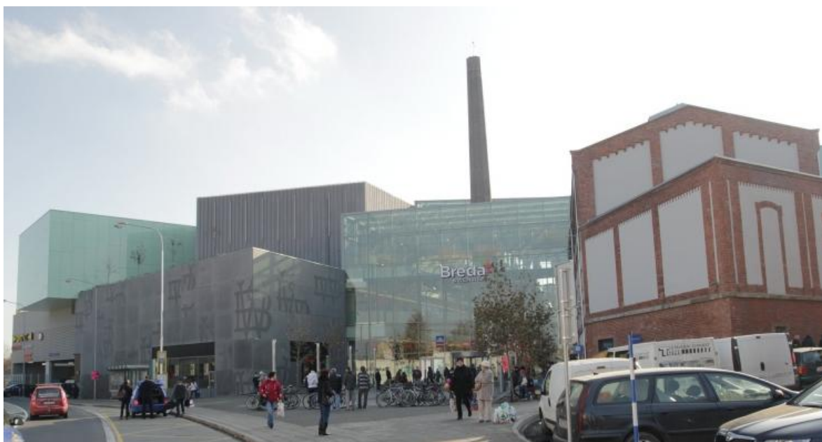
příloha č. 3 - Pohled z ulice Nákladní na OC Breda & Weinstein
