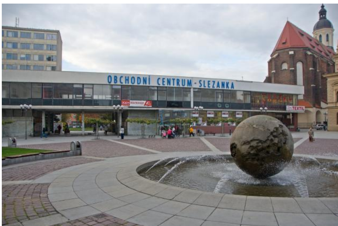
Příloha č. 4 - Budova nákupního střediska Slezanka na Horním náměstí (výstavba počátkem 70. let)
