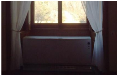
Obrázek 2. 2: Akumulční kamna, místnost č. 10102, původní stav
