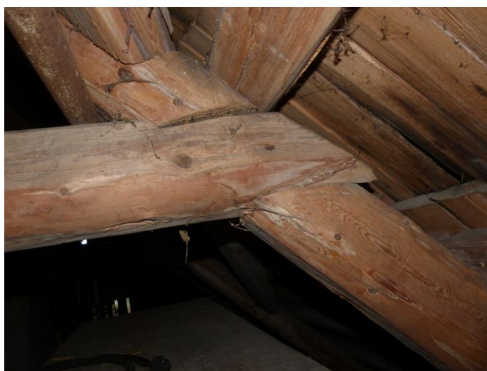
Obr. 22: Spojení krokve a hambalku rybinovým plátem
