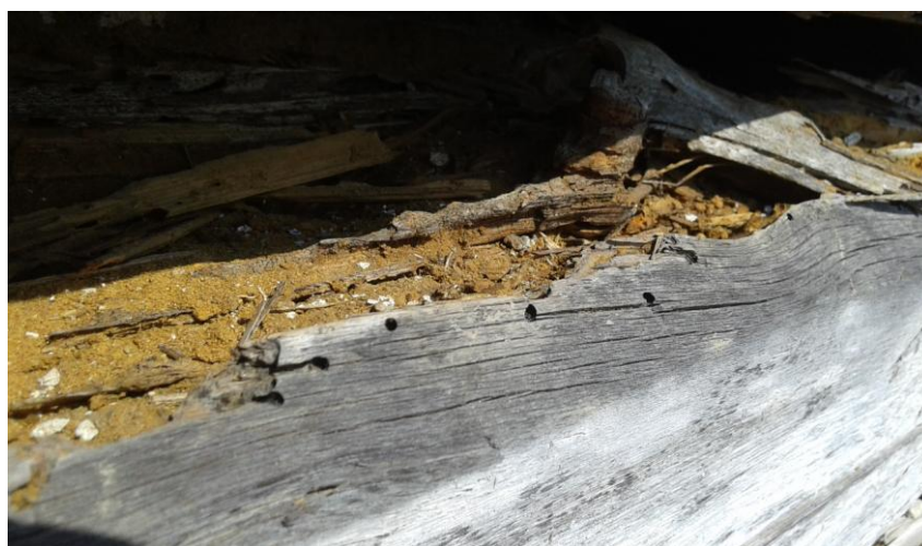
Obr. 26: Oválný výletový otvor v roubení
