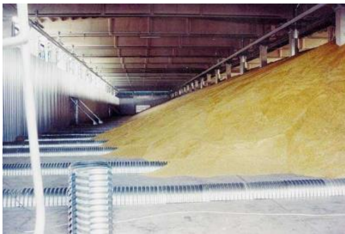
Obrázek 6: Halový sklad s nadúrovňovými kanály [23]
