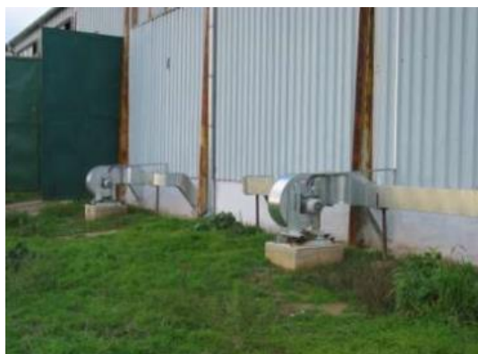
Obrázek 8: Radiální ventilátory umístěné vně skladu [23]
