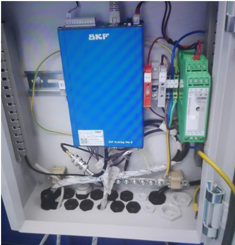
Obr. 19) Zapojený Multilog IMx-8 ve firmě EMKO Case
