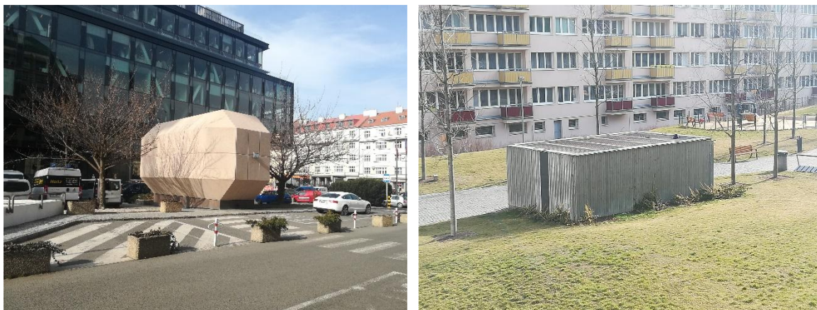
Obr. 3 - Dva výduchy vzduchotechniky stanice metra Dejvická
