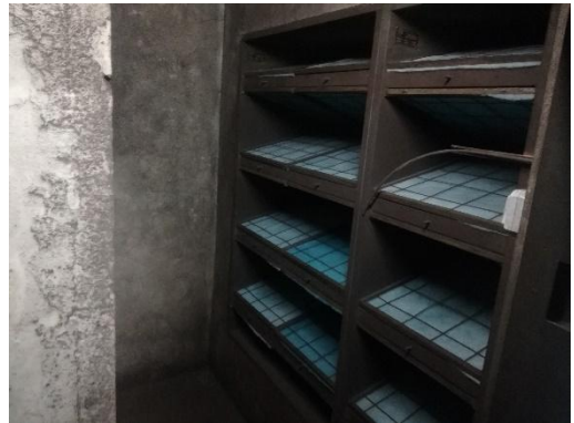
Obr. 10 - Filtrační stěna přívodu vzduchu
