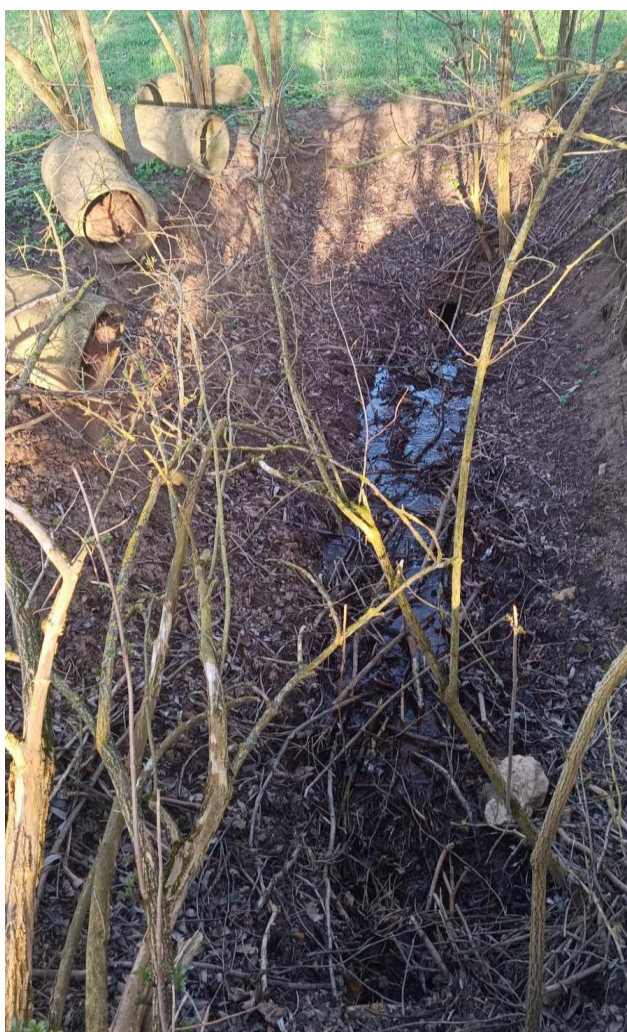
Foto 35: Odstranění zatrubněné části Kosteckého potoka (Formánek, 2024)
