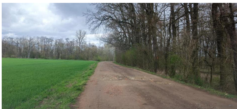
Foto 11: Místní komunikace MK2 s opravami vozovky (Formánek, 2024)
