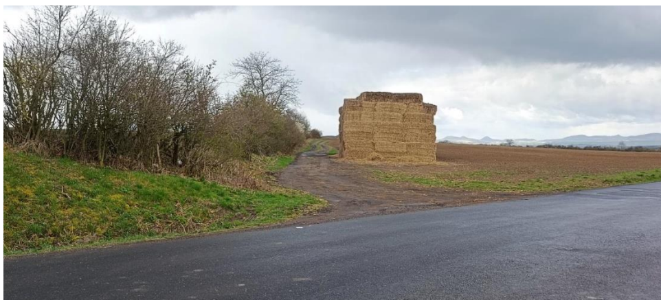
Foto 16: Hlavní polní cesta HPC 2 napojení na silnici III / 23745 (Formánek, 2024)
