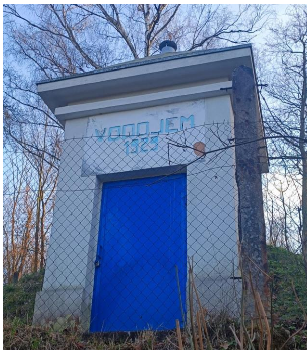
Foto 39: Vodojem pro obec Kostelec nad Ohří (Formánek, 2024)
