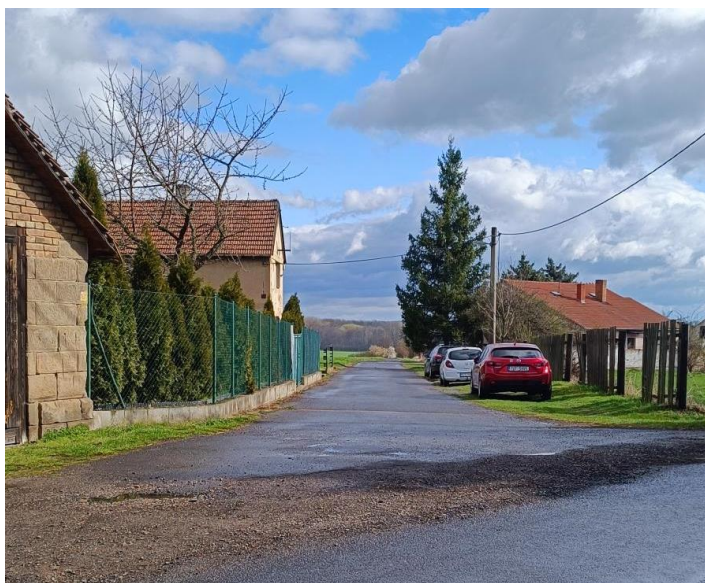
Foto 8: Místní komunikace MK1 v obci (Formánek, 2024)
