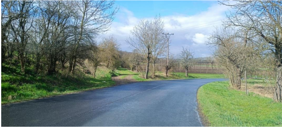
Foto 20: Hlavní polní cesta HPC 4 napojení na silnici III / 24612 (Formánek, 2024)
