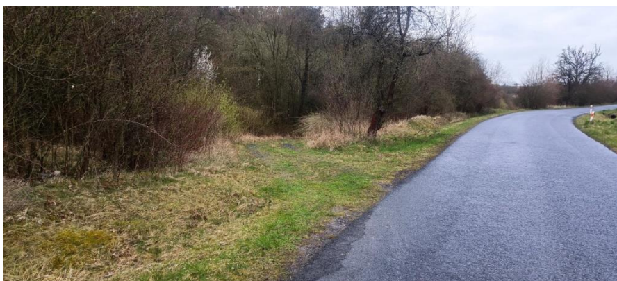
Foto 22: Hlavní polní cesta HPC 5 napojení na silnici III / 23746 (Formánek, 2024)
