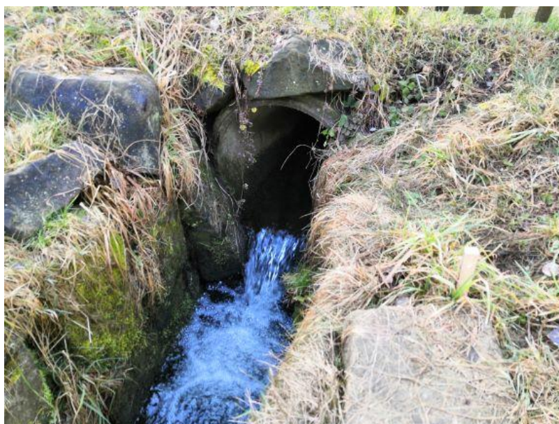
Obrázek 18 Fotografie příčný profil č. 3 - za propustkem
