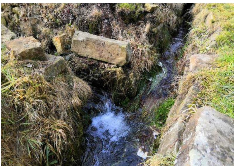
Obrázek 25 Fotografie SO 02 - soutok - pohled proti toku
