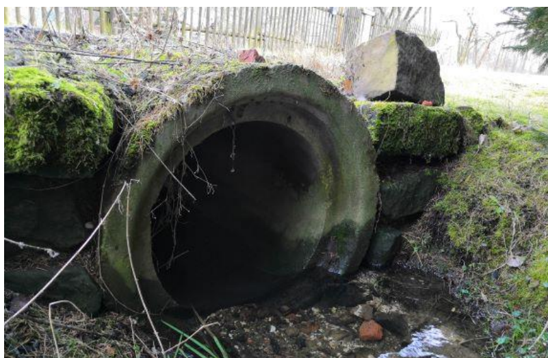
Obrázek 23 Fotografie SO 01 - trubní propustek
