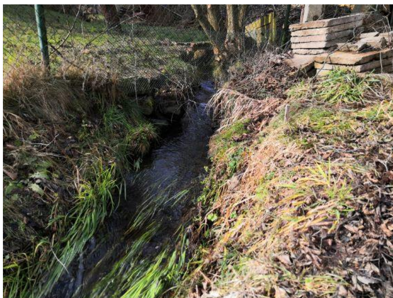
Obrázek 16 Fotografie příčný profil č. 1 - začátek úseku
