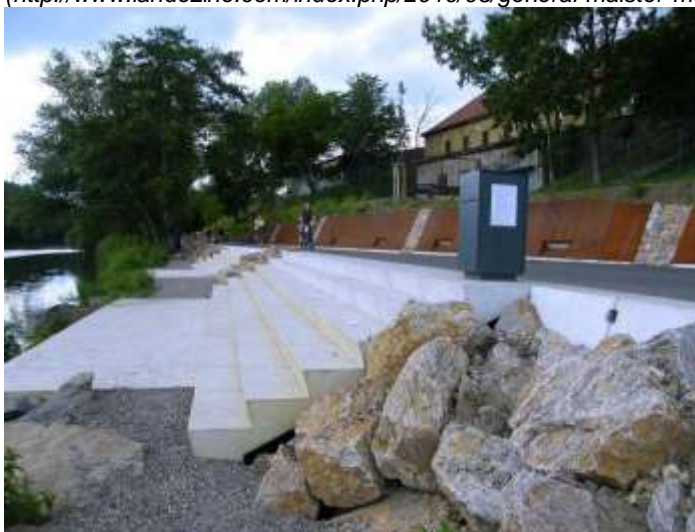
Obr. 94 - Nábreží Maxipsa Fika, Kadaň, ( http://fuksies.rajce.idnes.cz/Nabrezi_MAXIPSA_FIKA,_reka_OHRE,_KADAN#110612_016.jpg )
