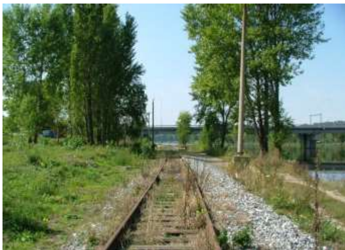
Obr. 47 – Holešovické nábřeží s železniční vlečkou ( http://www.prazsketramvaje.cz/ view.php?cislocclanku=20060410 16 )
