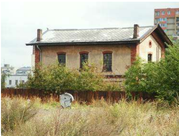
Obr. 59 - Kulturní památka - Bubenská nádražní vodárna ( https://commons.wikimedia.org/wiki/Category:PrahaBubny_(train_station)Bubny_(train_station) )
