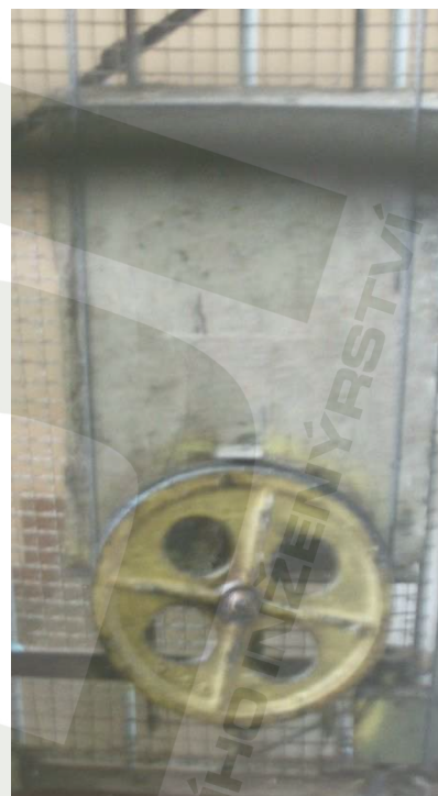
Obr. 11. Napínač lana omezovače rychlosti
