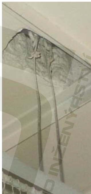
Obr. 7. – Vodítka protiváhy
