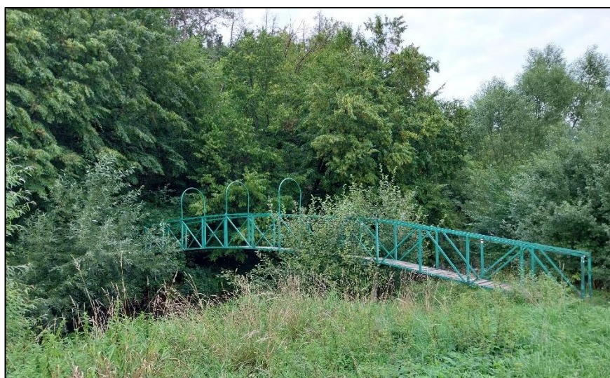
Foto 8: Běřín, Kubova lávka pod Vinicí v roce 2023
