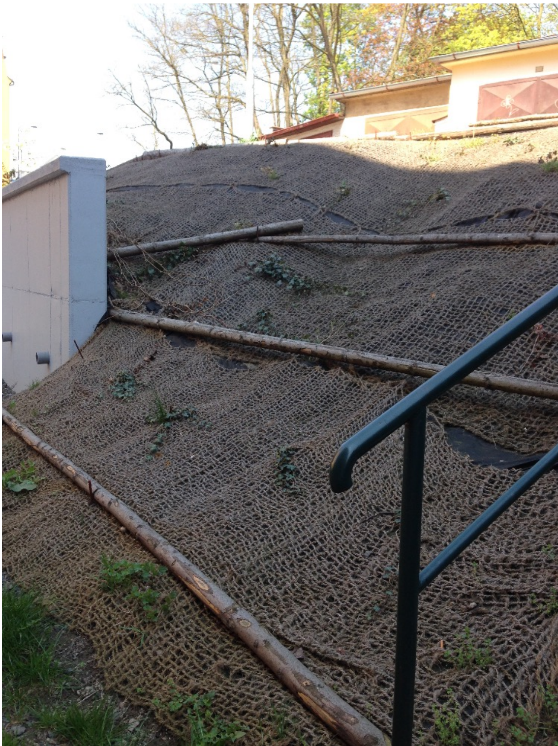
Obr. 19: Protierozní opatření u cesty s opěrnou zdí, K. Vary (vlastní, 2018)
