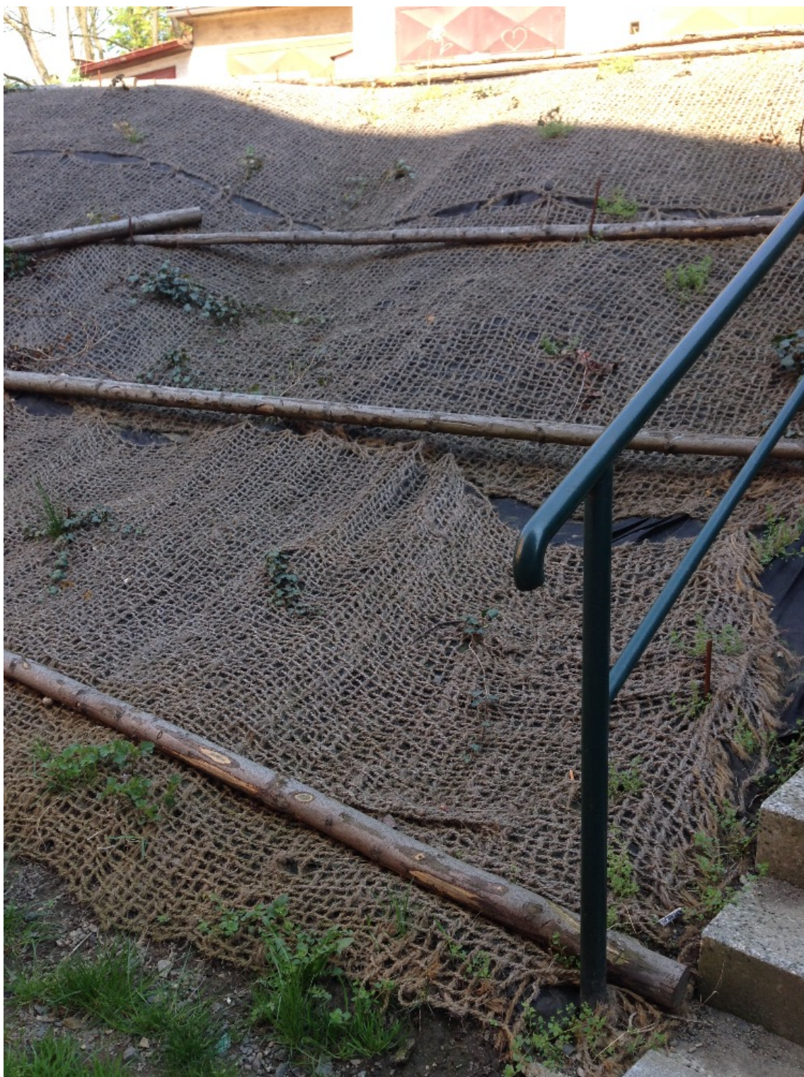
Obr. 18: Protierozní opatření u cesty, K. Vary (vlastní, 2018)
