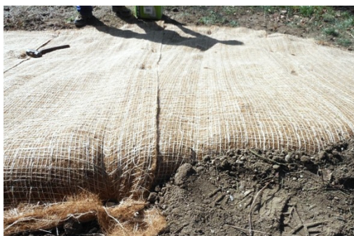
Obr. 11: Geotextilie z kokosových vláken a juty (Geomall, 2017)
