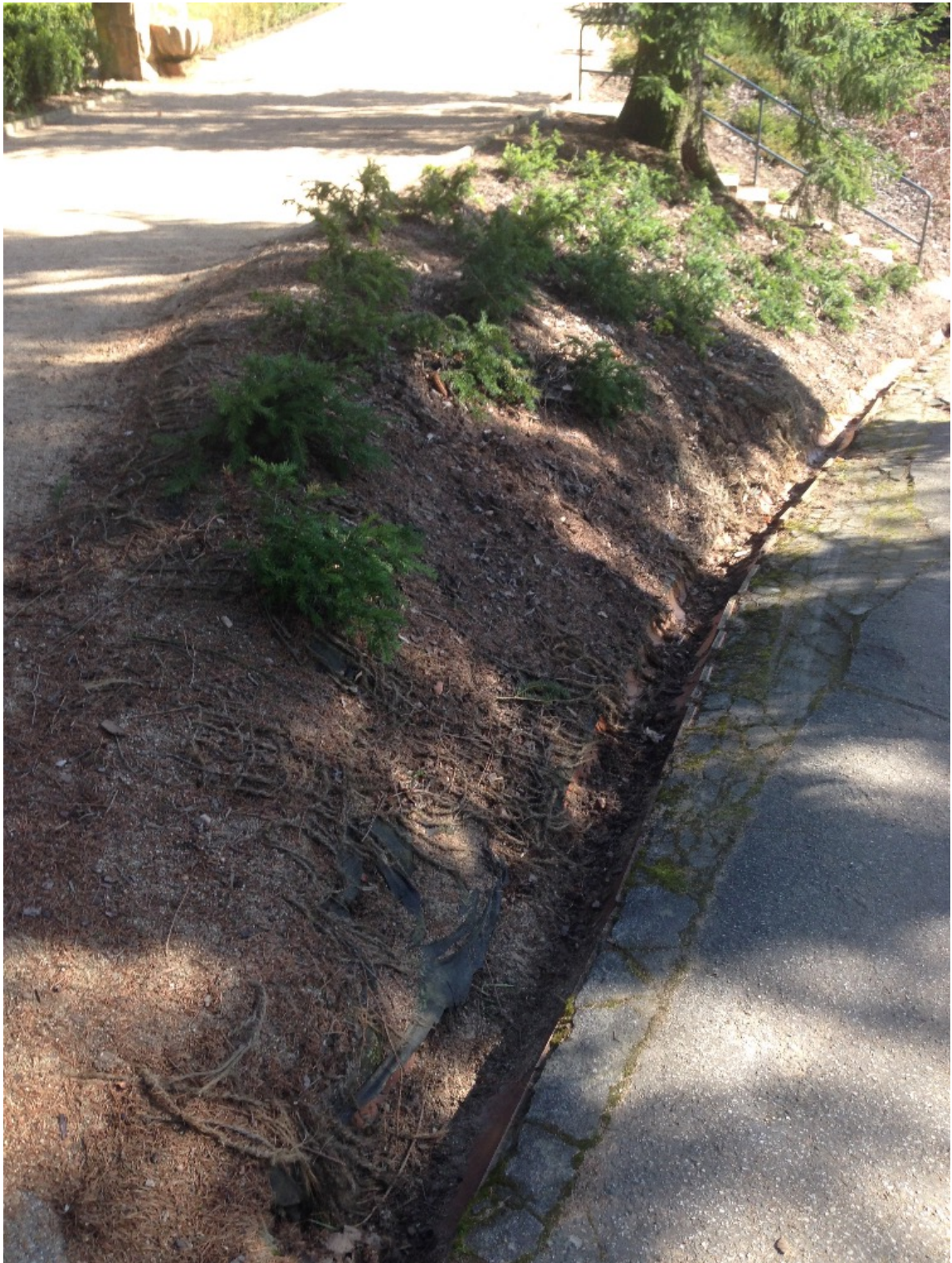
Obr. 14: Protierozní opatření mezi chodníky, Luhačovice (vlastní, 2017)
