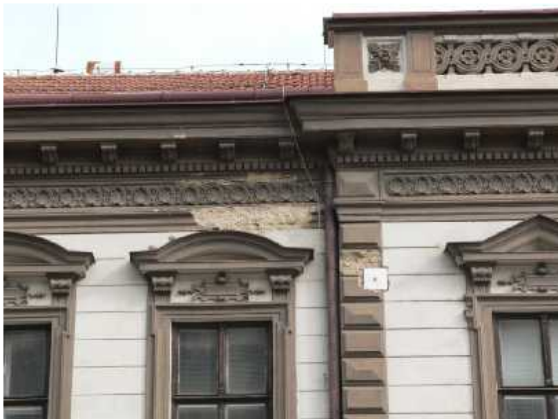
Obr. č. 80 – detail ocelové kotvy táhla
