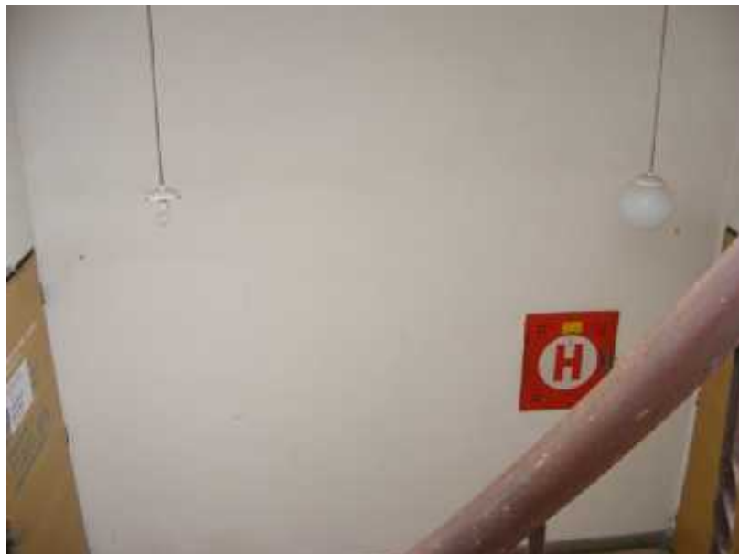
Obr. č. 41 – pohled na stěnu
