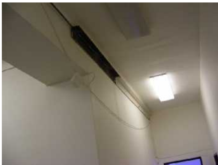
Obr. č. 53 – statické zajištění objektu
