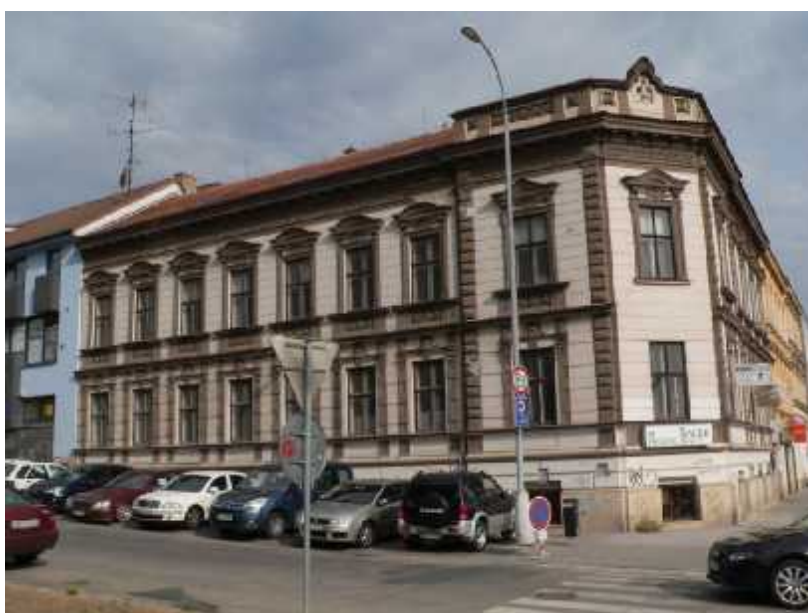
Obr. č. 78 – jižní pohled
