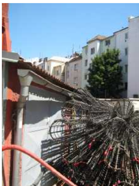
Obr. č. 38 - armokoše
