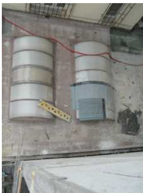
Obr. č. 37 – nosník na střeše
