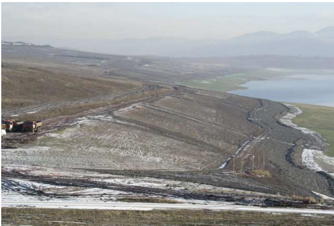
Obr.25 Sanace svahů
