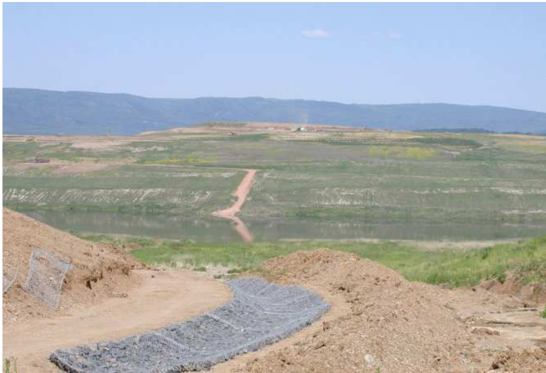
Obr.24 Odvodňovací příkop
