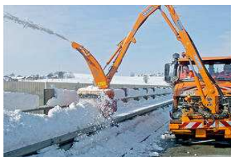
Obr. 22 Mulag – údržba komunikace
