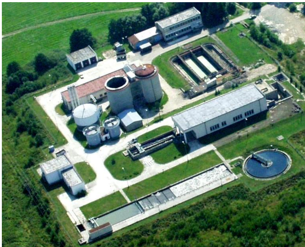
Obrázek 4: ČOV Tachov před rekonstrukcí – celkový pohled (foto: J. Kronďák)
