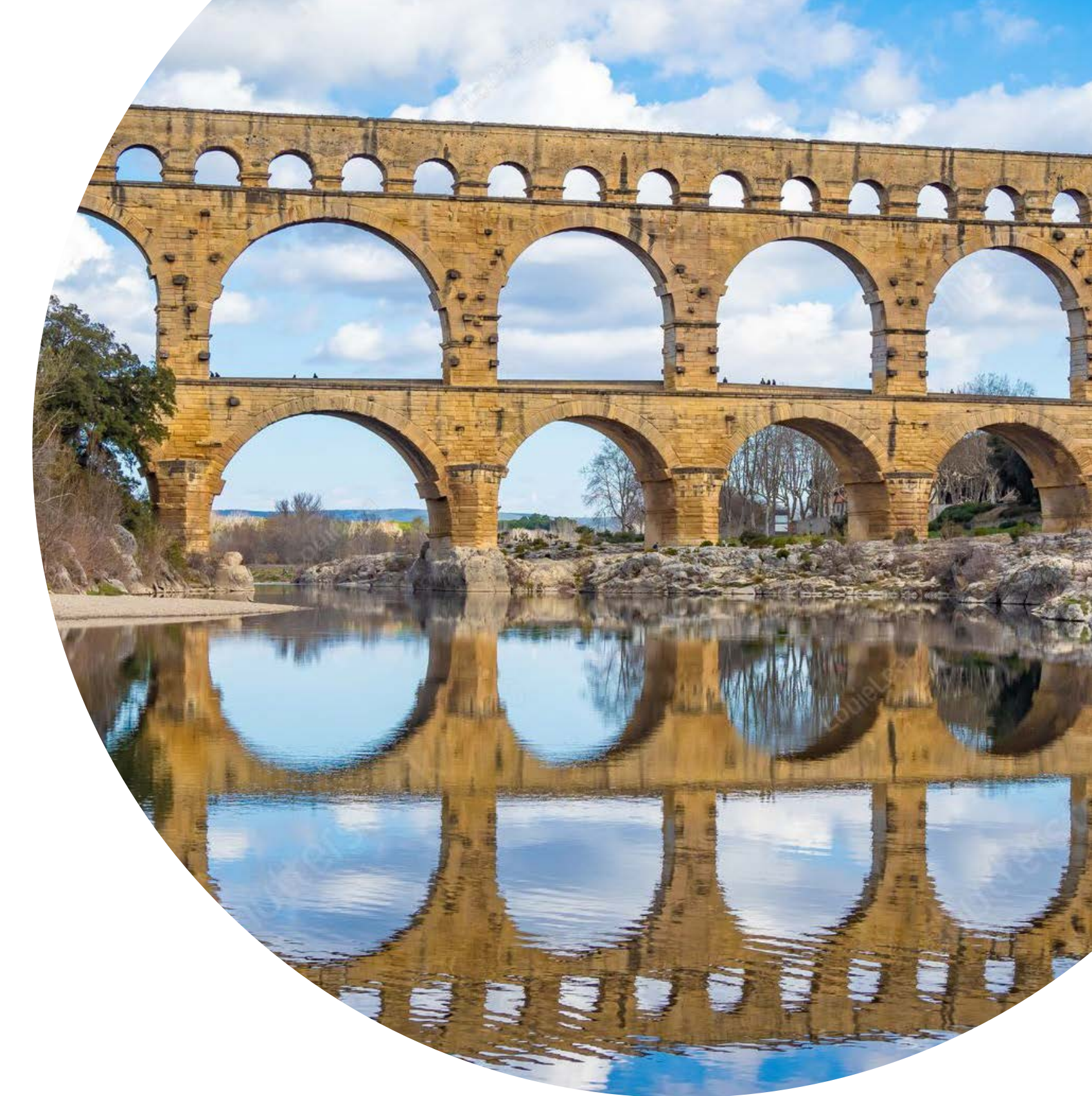
Obrázek č. 3 - Aquadukt (Zdroj: https://www.shutterstock.com/cs/search/aquadukt )
