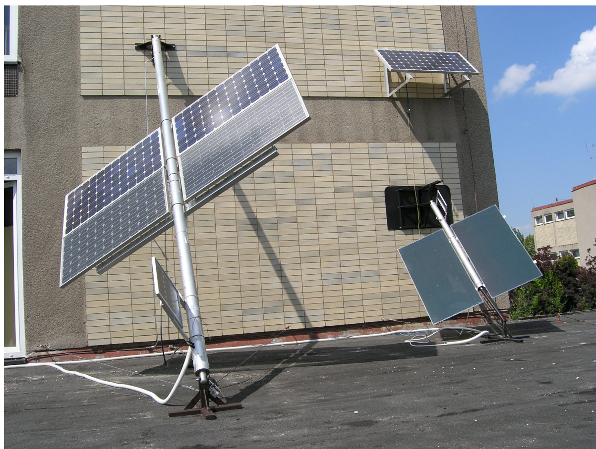
Obr. 5 Ukázka: vlevo a vpravo dole - rotační držák FV - vpravo nahoře statické uchycení FV (Technická fakulta ČZU)
