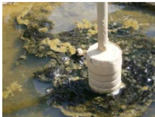
Obr8: rozbitý přívod plynu
