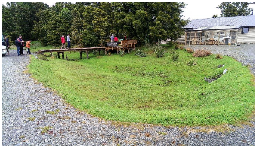
Obrázek 8 - Povrchová vsakovací nádrž [21]
