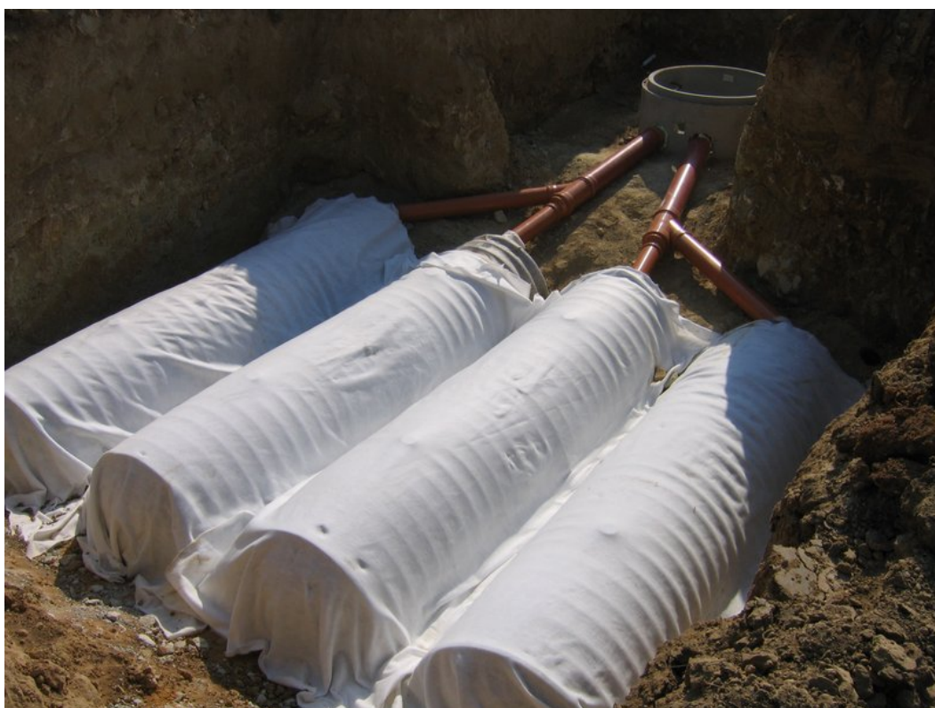
Obrázek 12 - Vsakovací systém AS-KRECHT [24]
