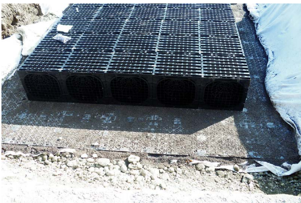
Obrázek 14 - Vsakovací boxy [21]
