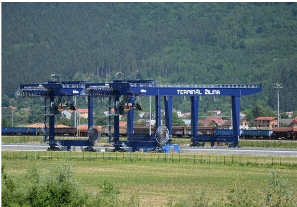
Obr. 1.13 Terminál intermodálnej prepravy Zdroj: [30].
