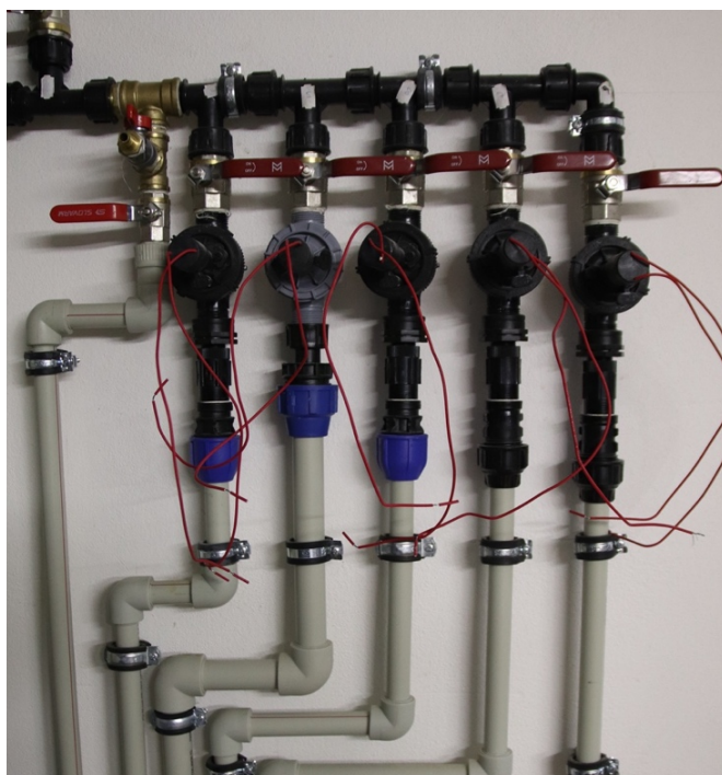
Obrázek 2.18 Zapojení části rozvodu vody se spínacími ventily
