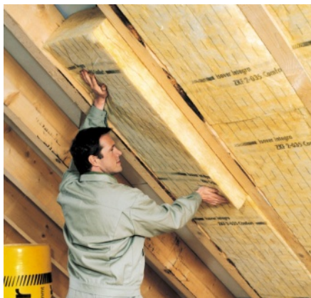
Obr. č. 11 - Ukázka montáže skelné izolace mezi krokve
