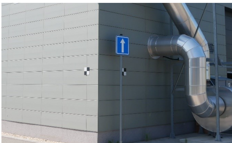
Obrázek 18: Příklad umístění terčů na budovách.
