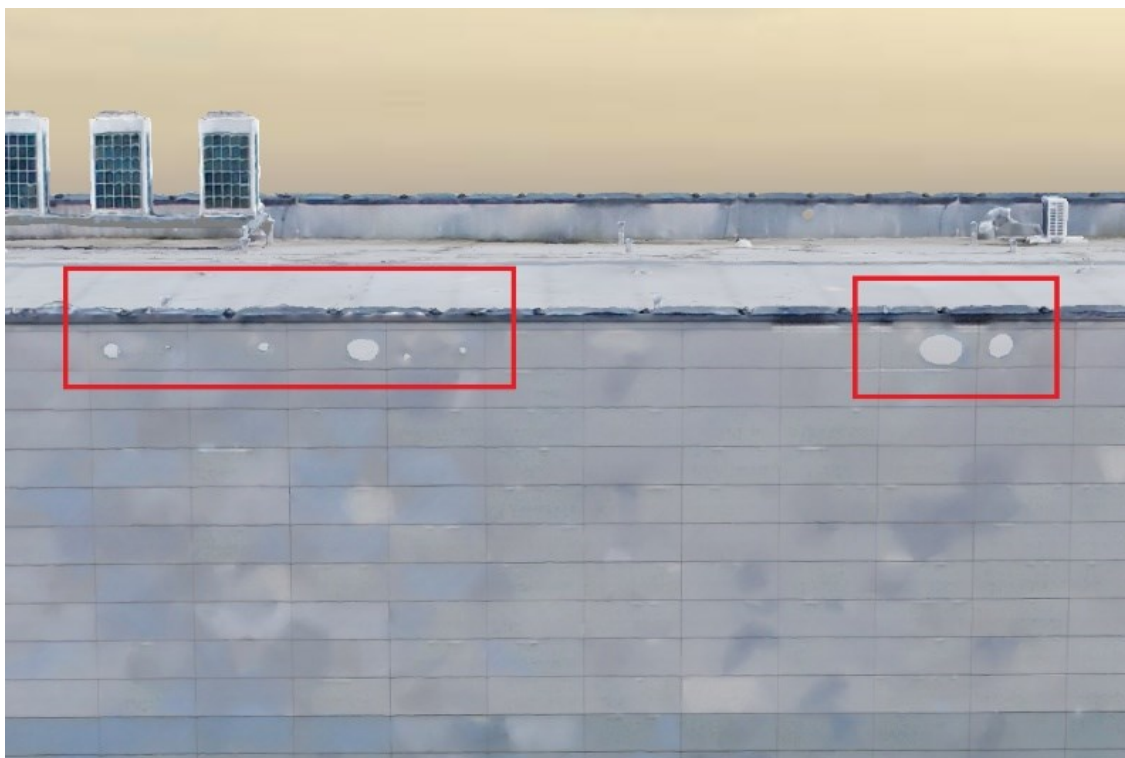
Obrázek 30: Otvory na fasádě budovy H.
