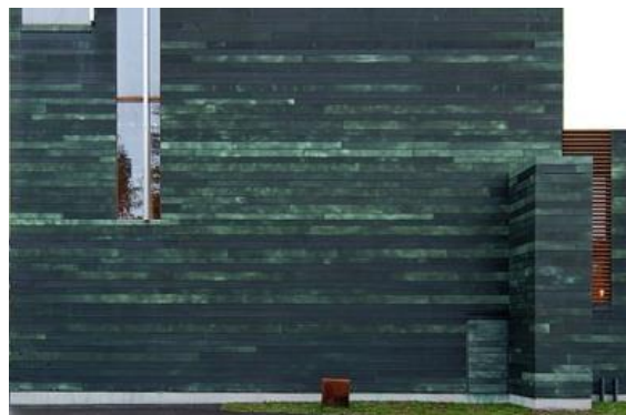
Obr. 7 Fasádní obložení měděnými pásky
