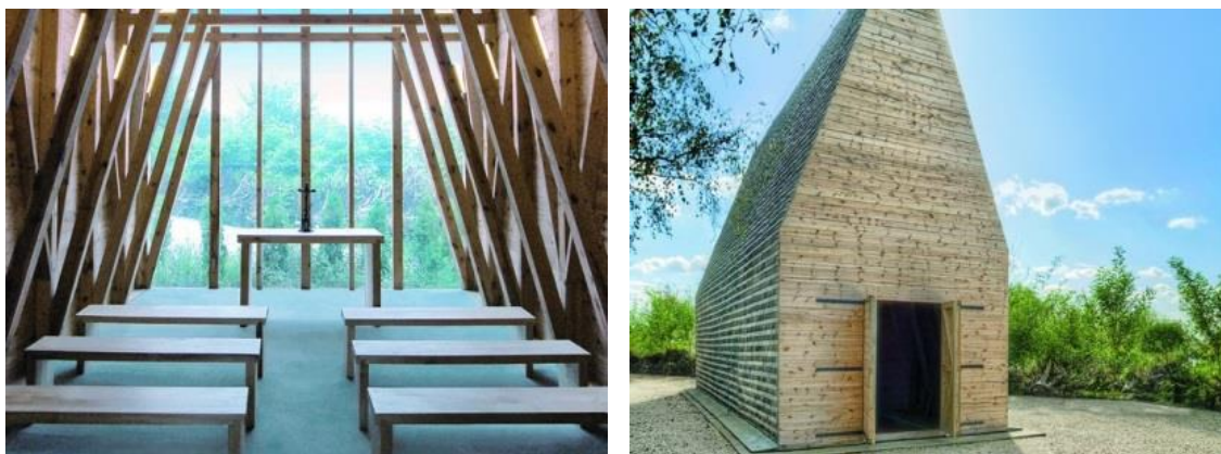
Obr. 33 Kaple v Tarnów, jižní Polsko, rámová konstrukce z masivního dřeva. 30
