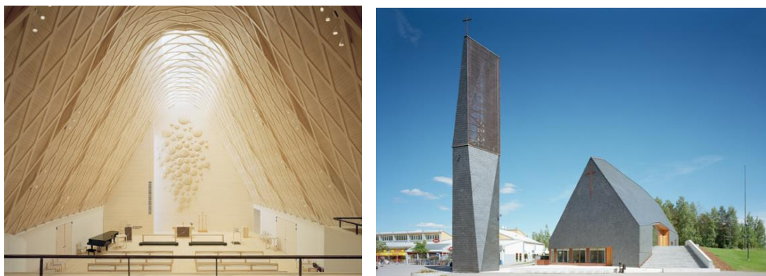
Obr. 28 Dřevěná modlitebna v Jyväskylä, Finsko, rámová konstrukce s příhradou LLD. 25
