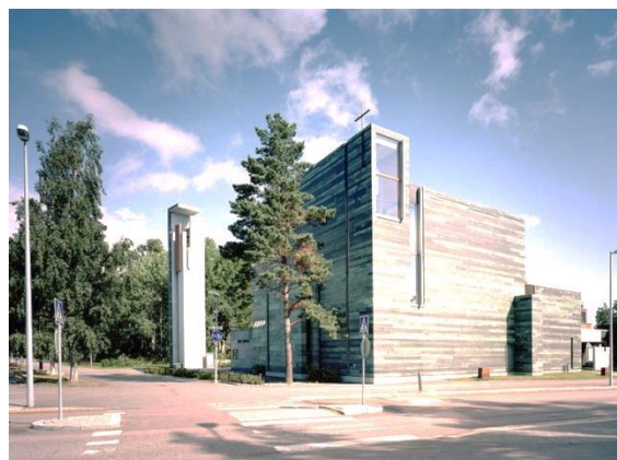
Obr. 4 Pohled z přilehlé silnice
