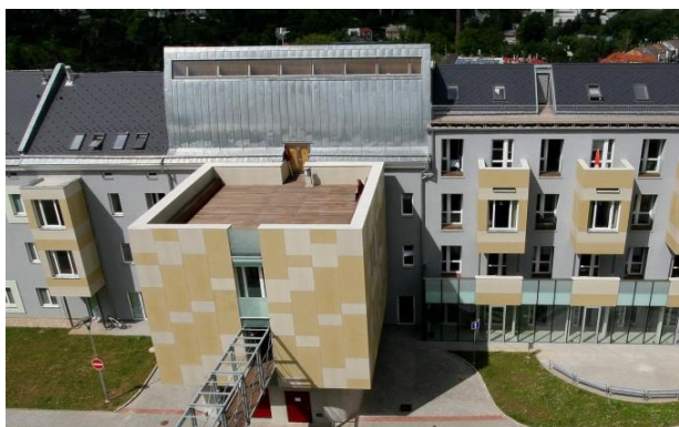
Obr. 25 Pohled na kapli na střeše centra pro seniory 23
