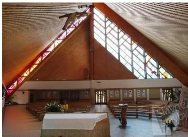
Obr. 19 Pohled na lepený a příhradový nosník
