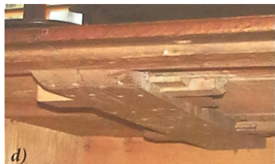
Obrázek 35: Horní klínový spoj (L. Losos, Praha 2013)
