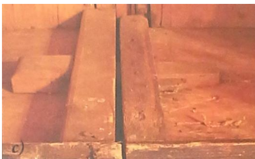
Obrázek 34: Spodní spoj dvou korpusů pomocí klínu (L. Losos, Praha 2013)
