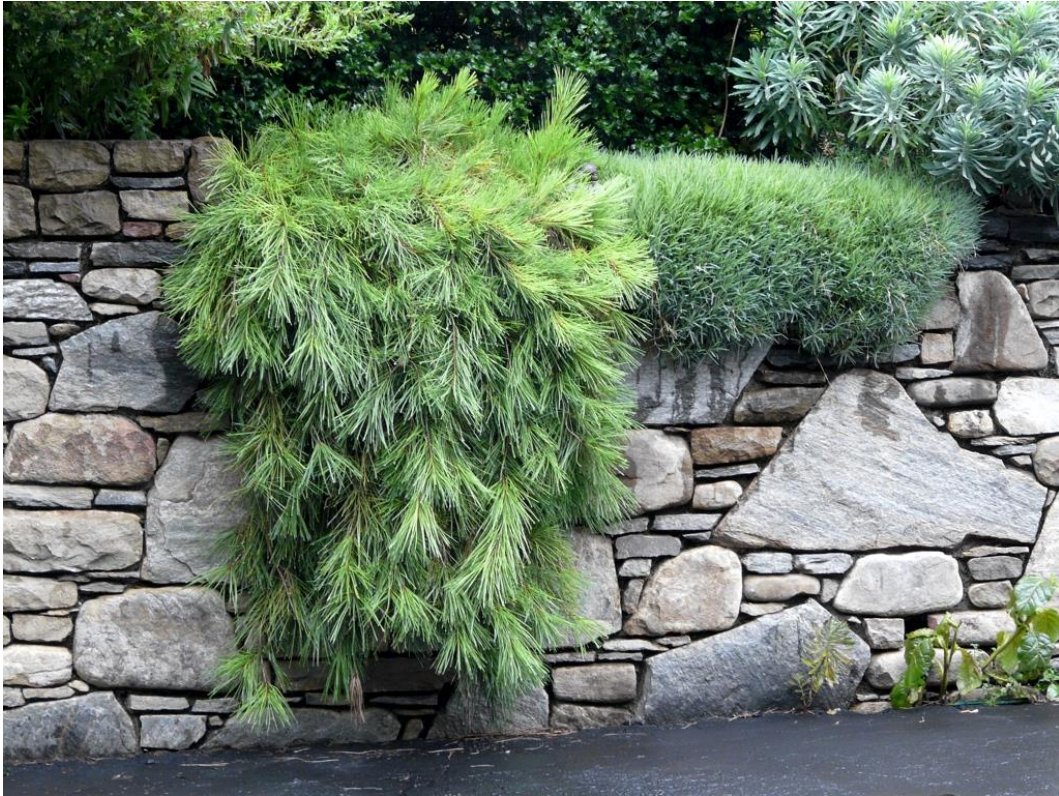
Obr. č. 16: Opěrná stěna z kamenů
