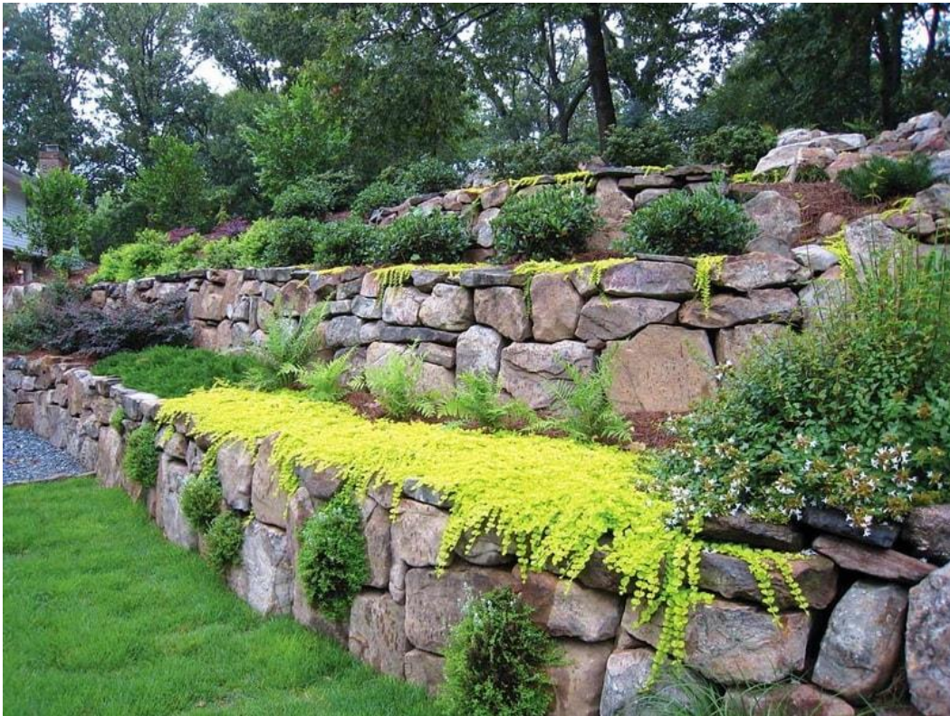
Obr. č. 17: Opěrná stěna z kamenů (a)
