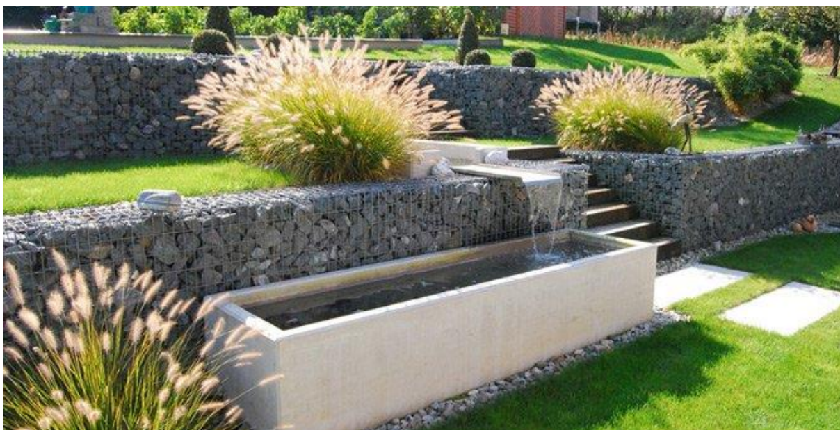
Obr. č. 19: Gabiony v terénu
