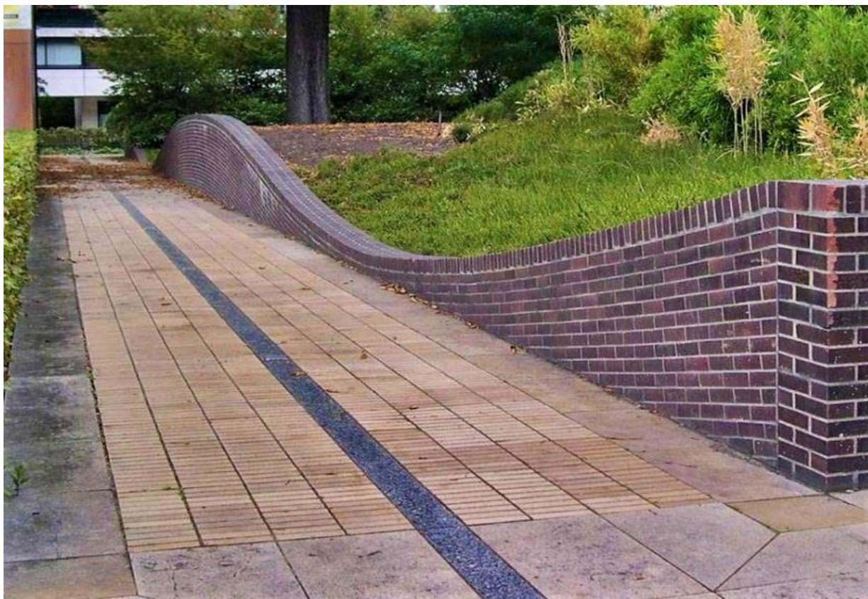
Obr. č. 18: Dekorativní opěrná zed' z cihel
