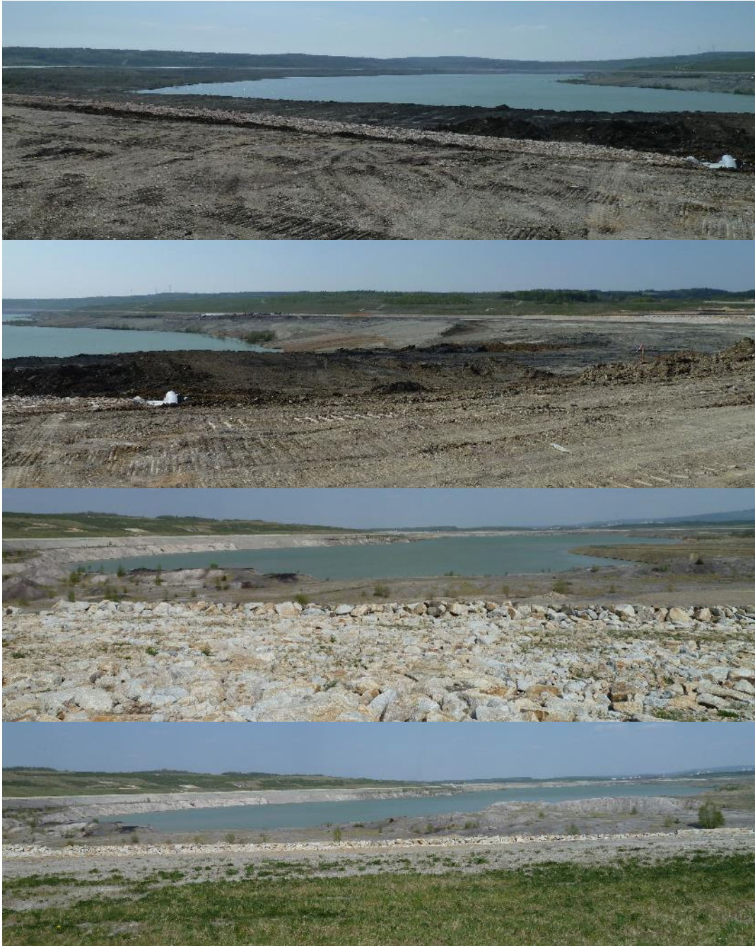
Příloha 50: Úroveň rekultivace zbytkové jámy Medard-Libík, duben 2011. Pohled ze západního břehu východním směrem.
