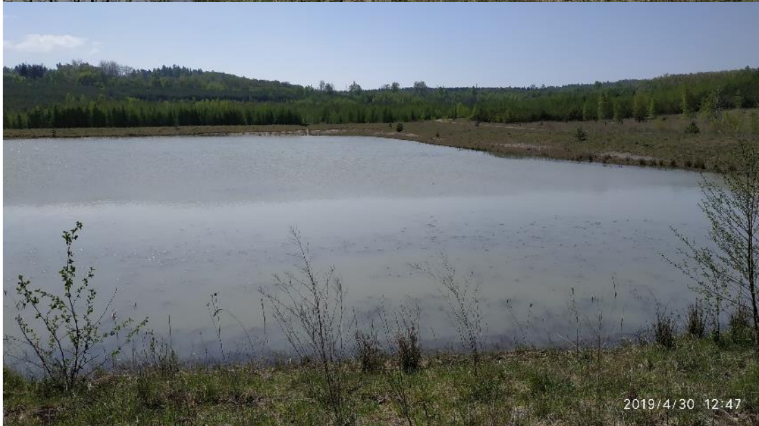
Příloha 46: Vodní nádrž vybudovaná na kótě 415 m n.m. nad jihozápadní částí jezera. Účelem je odvodnění svahů.
