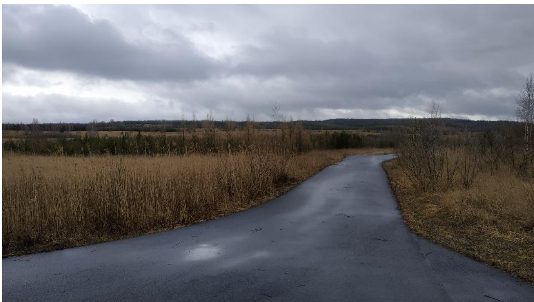
Příloha 52: Dráha pro inline bruslaře v okolí nádrží. V pozadí lítovská výsypka.
