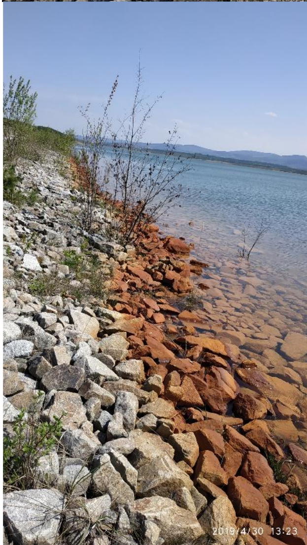
Příloha 39: Břehové opevnění s charakteristickým zabarvením vodou ze štolý Josef
