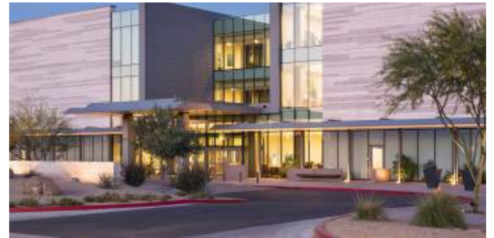
Obr. 11: Hlavní vchod nemocnice v Austrálii. Zdroj: https://www.tetrattech.com/ .
