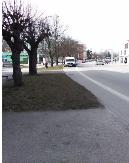
Obr. č. 38 – Asfaltová úprava na ulici Svobody, Třeboň (archív autora)
