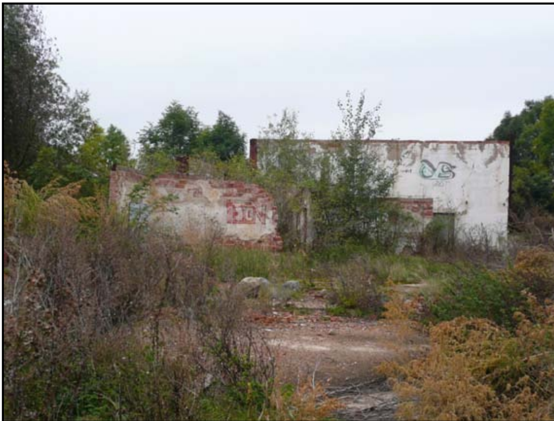
Obr. 33 BF2 Hlušice - výrobná granulí
