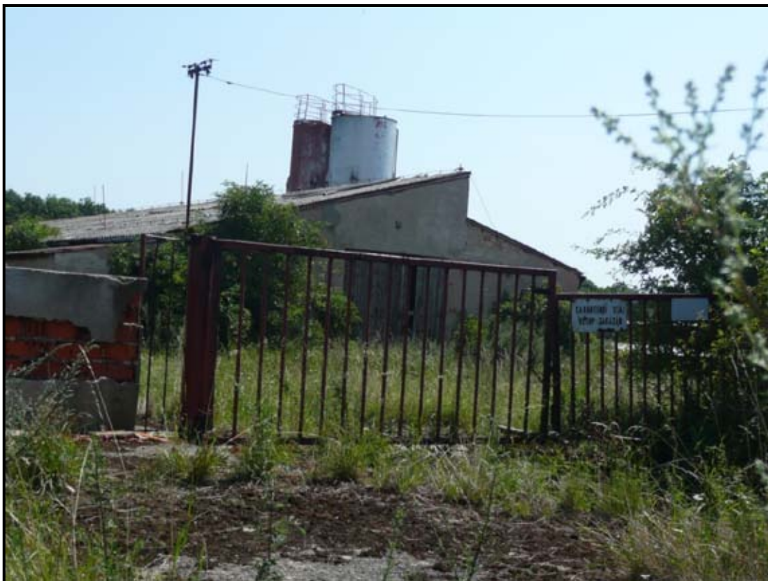
Obr. 54 BF12 Nový Bydžov (KÚ Vysočany) - zemědělský areál
