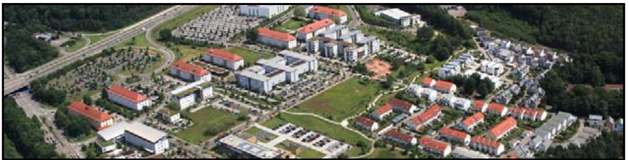
Obr. 2 Revitalizovaná kasárna, nyní PRE-Park Holtzendorff ( www.pre-projekte.com )
