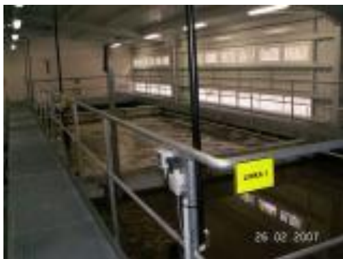
Obrázek č. 4 a č. 5: Příklady biologických reaktorů s denitrifikační a nitrifikační částí. Zdroj: URL 4
