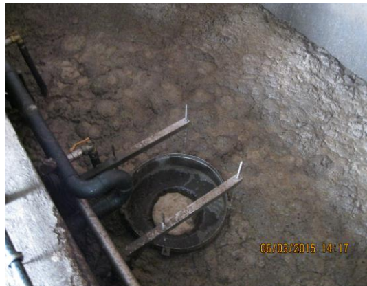
Obrázky č. 23 a č. 24: Železobetonová monolitická nádrž s denitrifikací, nitrifikací, dosazovací nádrží a kalojemem (foto vlastní)
