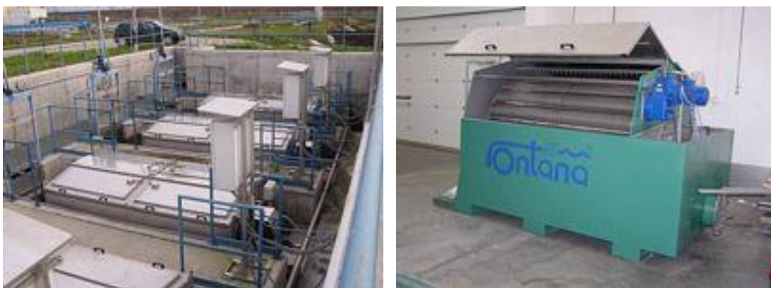
Obrázky č. 6 a č. 7: Příklady umístění mikrosít jako terciární stupeň dočištění OV a samotné mikrosíto spol. Fontana. Zdroj: URL 5
