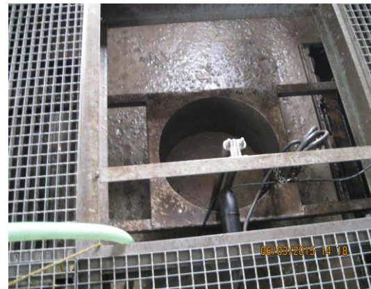
Obrázky č. 23 a č. 24: Železobetonová monolitická nádrž s denitrifikací, nitrifikací, dosazovací nádrží a kalojemem (foto vlastní)
