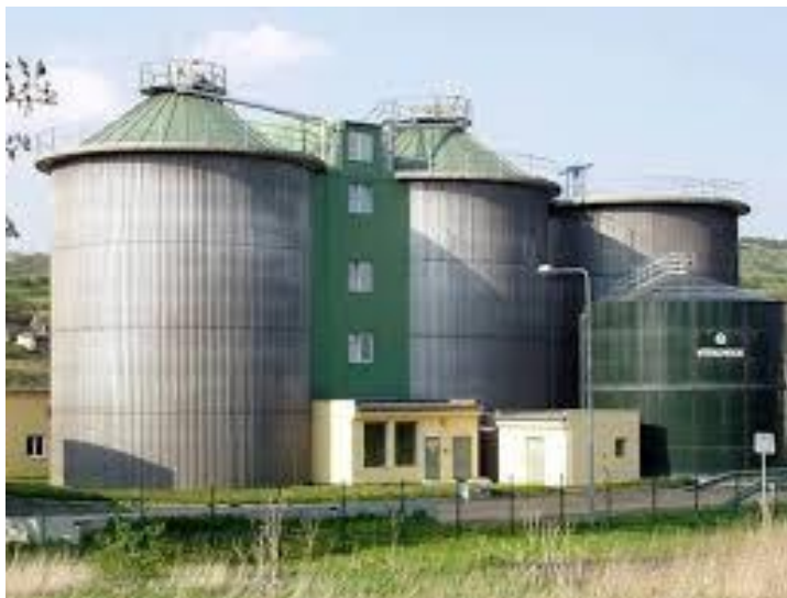
Obrázek č. 8: Příklad umístění kalojemů u ČOV. Zdroj: URL 6
