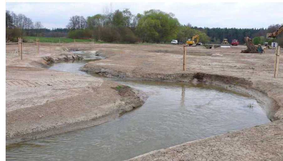
Obr. 3 Revitalizace obnovuje Stropnici jako zřetelně meandrující vodní tok, jehož členité koryto podporuje tlumivé rozlévání povodňových průtoků do okolní nivy. Převzato z: AOPK, 2015
