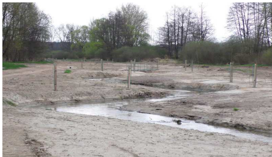
Obr. 1 Dokončovací práce na 1. etapě revitalizace Stropnice, duben 2014. Voda si sama dotvoří břehy koryta, nejsou-li dostatečně tvarově členité. Převzato z: AOPK, 2015
