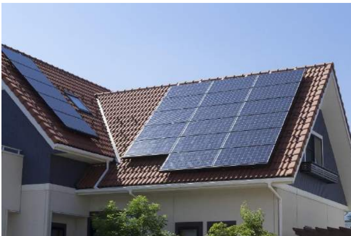
Obrázek 18 Fotovoltaické panely na střeše rodinného domu
