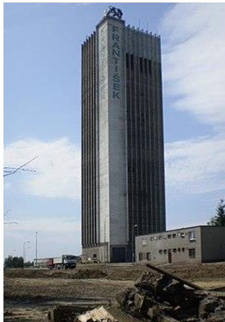
Obrázek 10 Těžní věž skipu s věžovou strojovnou
