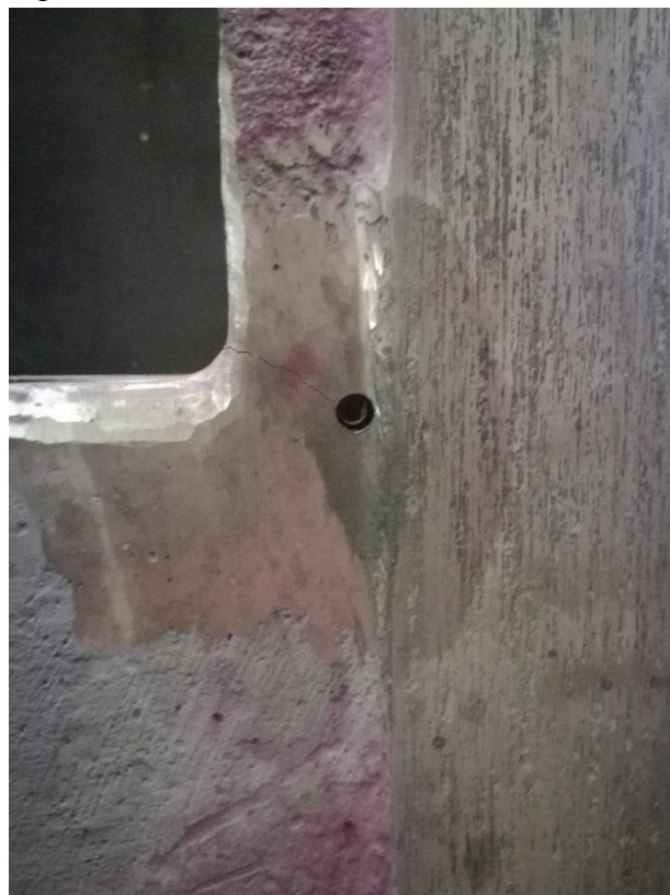
Obr. 87 – Odvrtání konce trhliny
