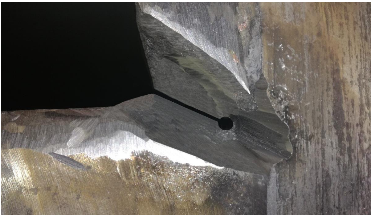
Obr. 90 – Zadní vnější pohled na provedený svarový úkos
