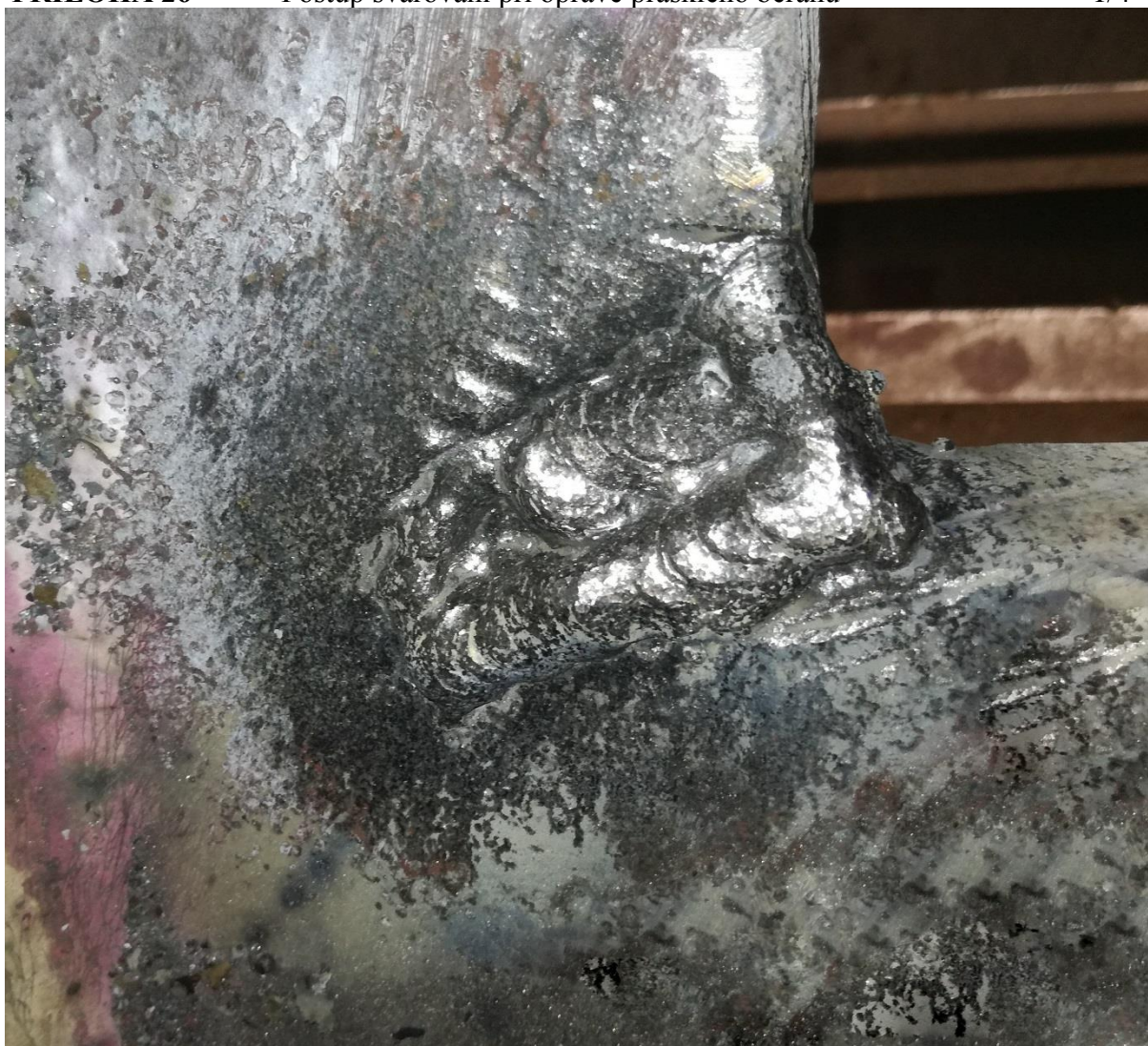
Dokončená vnitřní strana svaru.
