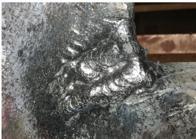
Obr. 93 – Dokončený svar z vnitřní strany
