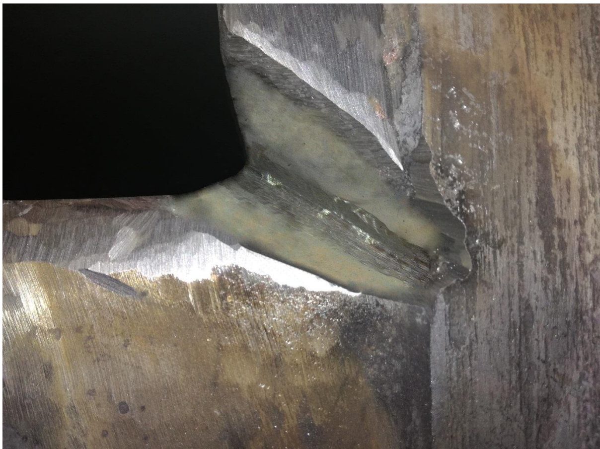
Vybroušení kořenu svaru po dokončení vnitřní strany.
