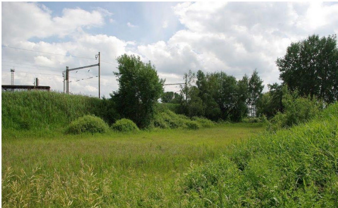
Obrázek 24 Všetatská černava – železniční násep
