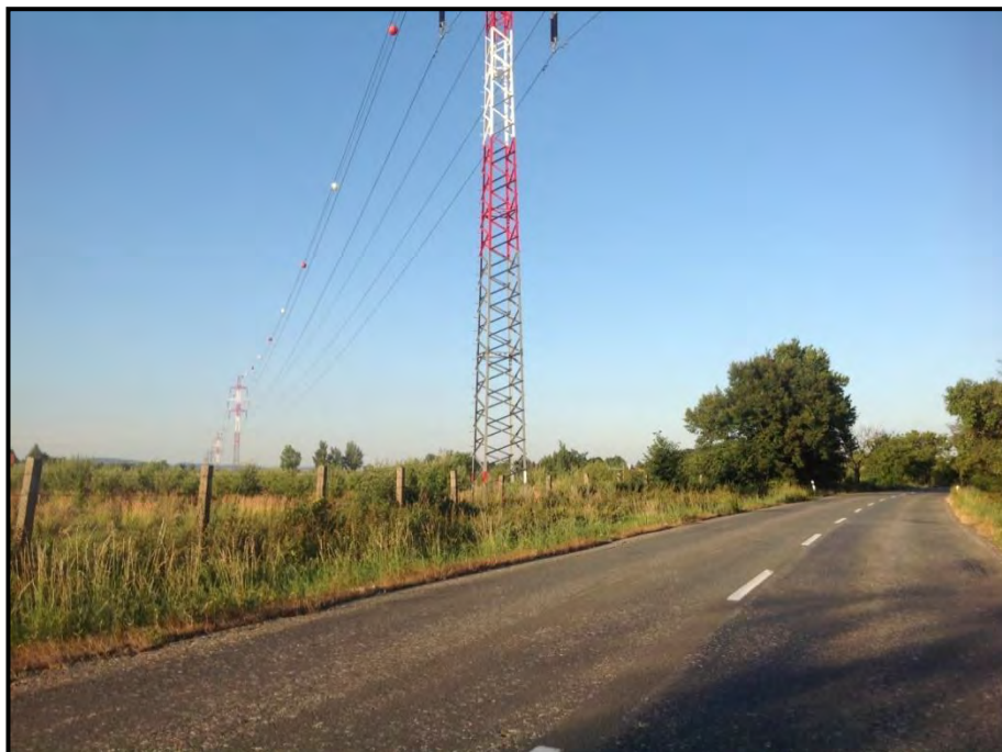
Obrázek 26 - Pohled na vedení VVN nad komunikací
