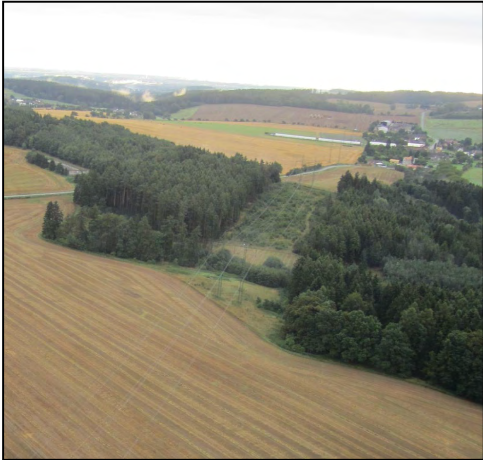
Obrázek 28 - Pohled na nadzemní elektrické vedení přes lesní pozemky
