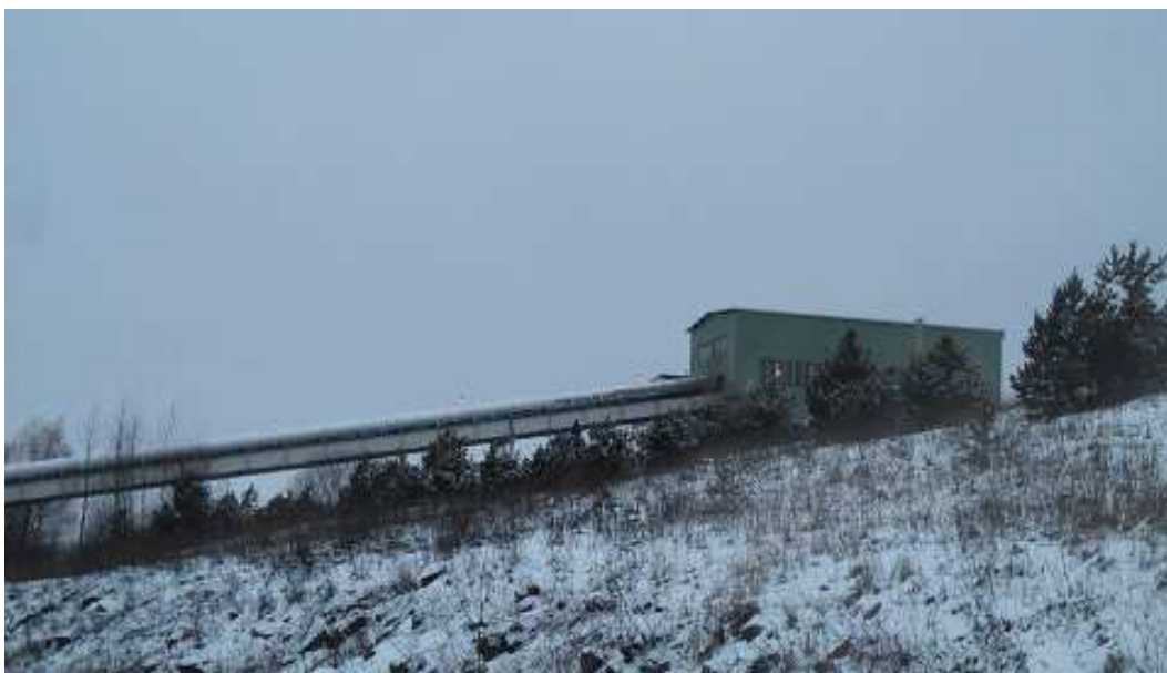
foto č.11: Zakrytované pasovky před nakládací stanicí Zdroj: autor
