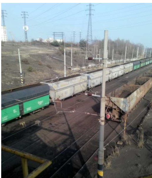
foto č.13: Pohled z NS na nezakrytý svah Zdroj: autor
