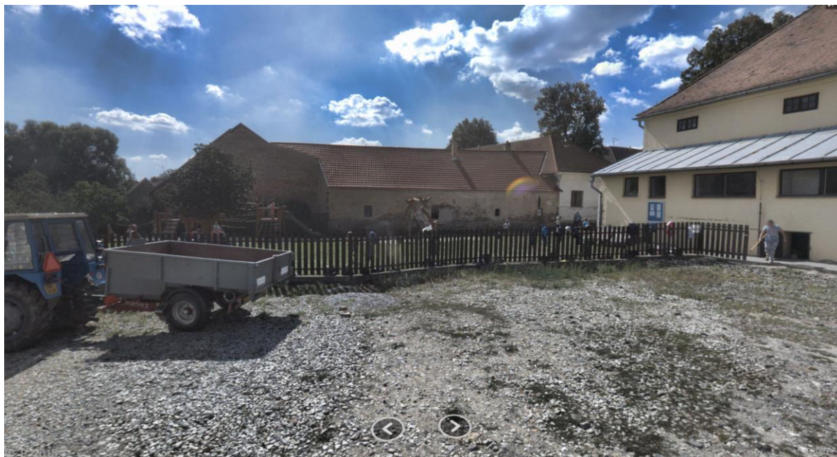
Obrázek 124: Fotografie okolí staveniště [ 1 ]
