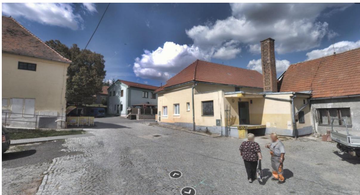
Obrázek 126: Fotografie okolí staveniště [ 1 ]
