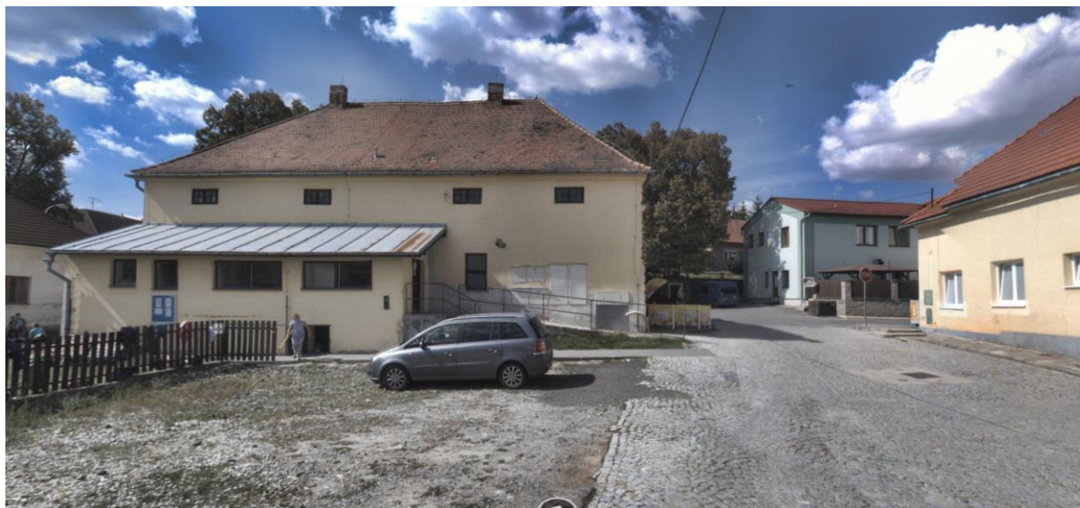
Obrázek 125: Fotografie okolí staveniště [ 1 ]
