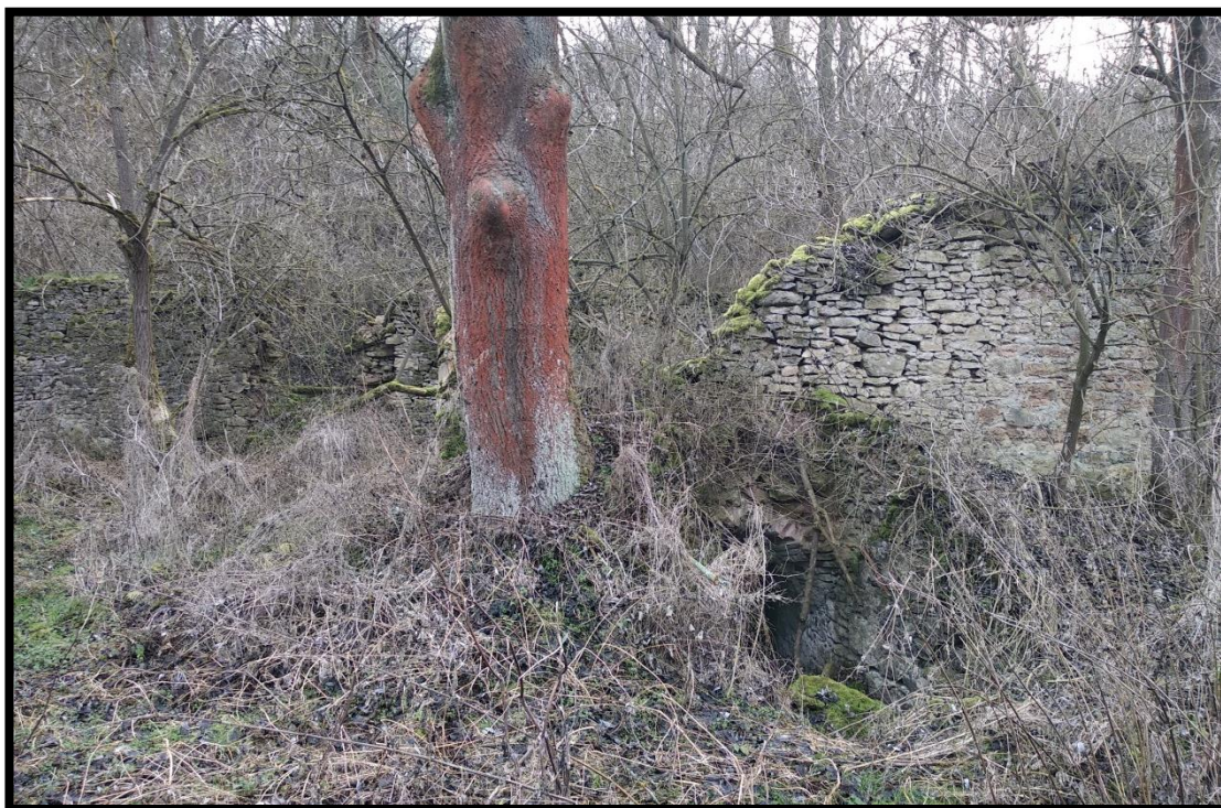
Obr. č. 56: Bývalý Hladkovský mlýn
