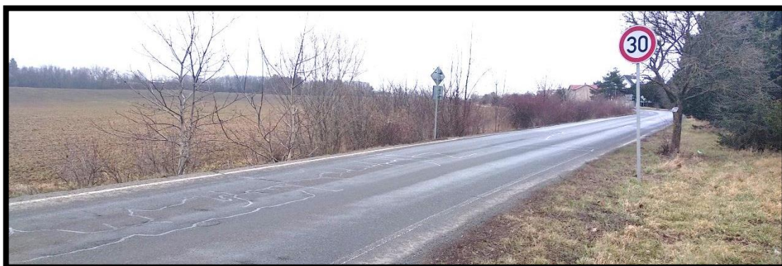
Obr. č. 20: Silnice III/0057
