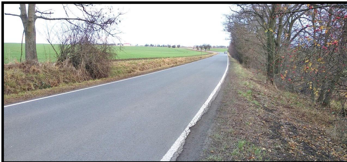
Obr. č. 22: Silnice III/00511
