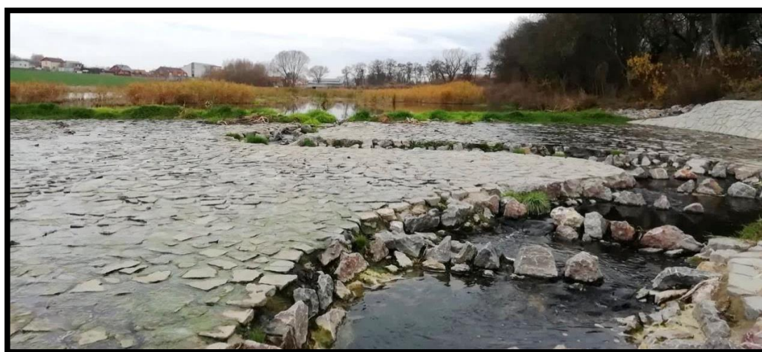
Obr. č. 90: Rybí přechod v K. Ú. Tachlovice
