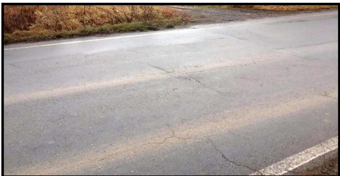
Obr. č. 21: Silnice III/00510
