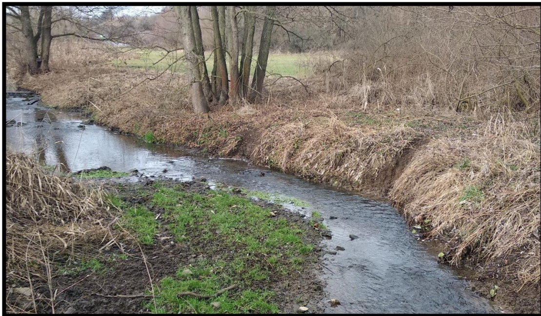
Obr. č. 51: Radotínský potok
