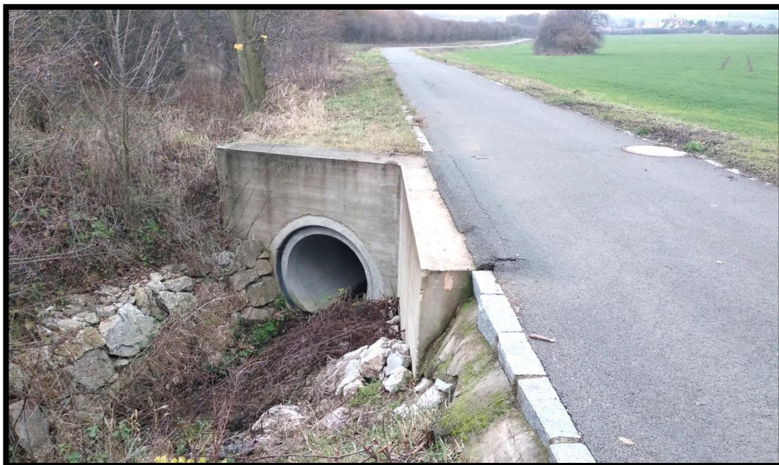
Obr. č. 27: Propustek pod polní cestou HC 4
